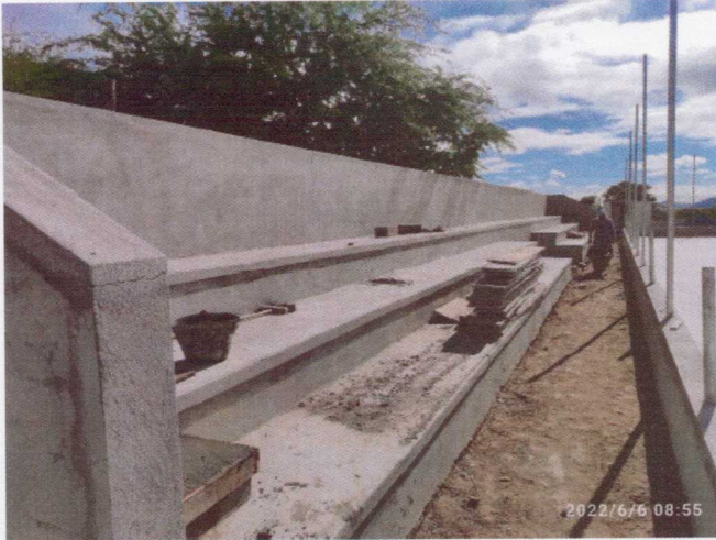
Foto 03- Vista parcial destacando a arquibancada em execução
