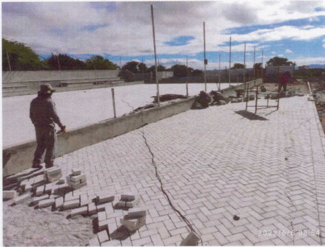
Foto 01 – Vista parcial destacando o assentamento do piso intertravado
