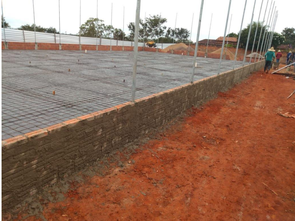
Foto 01 – Construção da mureta, estrutura do alambrado e estrutura do piso da quadra.
