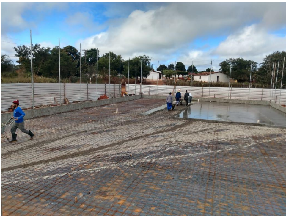
Foto 02 – Estrutura do piso da quadra.
