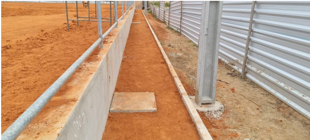
Foto 02 – Nivelamento do terreno.
