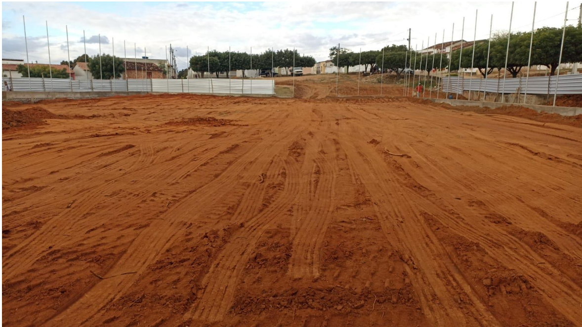
Foto 02 – Nivelamento do terreno.
