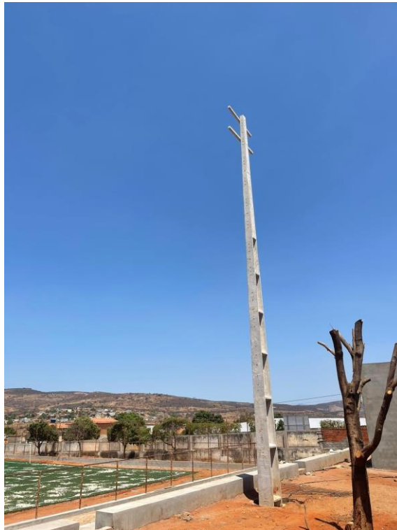
Foto 05 – Implantação do sistema de iluminação.
