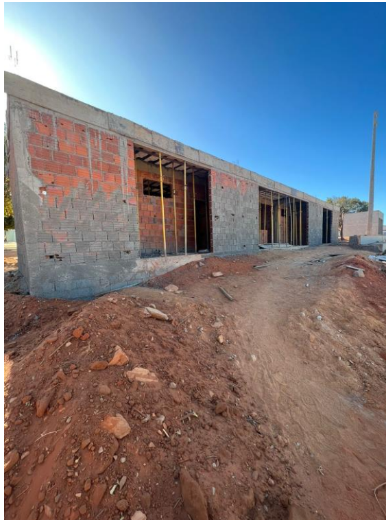
Foto 03 – Construção de sanitário público e bar.
