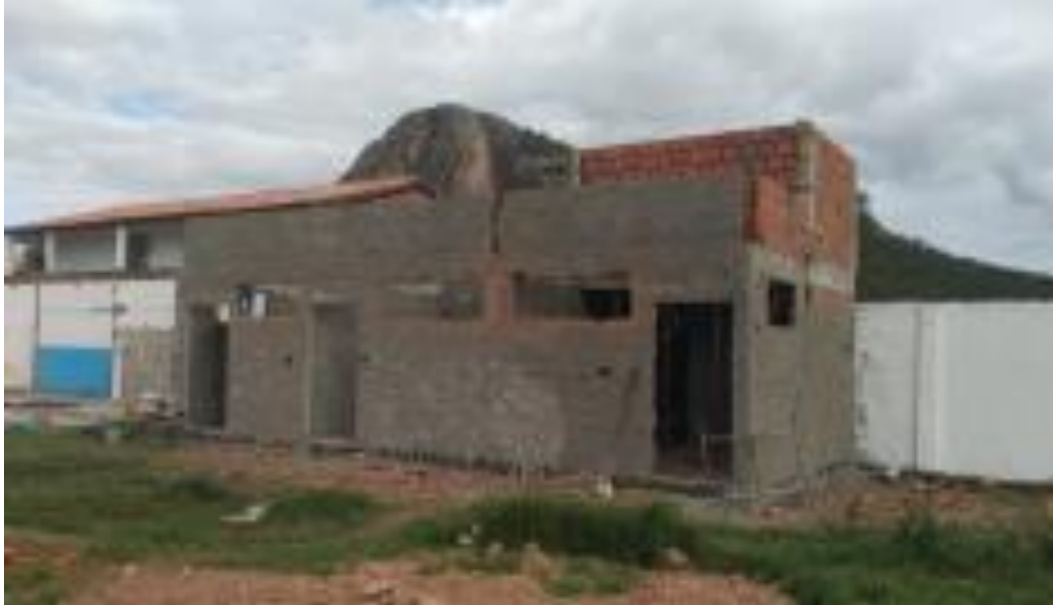
Foto 01 – Execução do vestiário.
