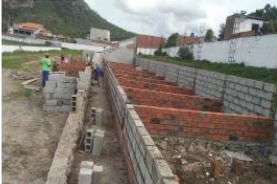
Foto 03 – Execução da arquibancada.
