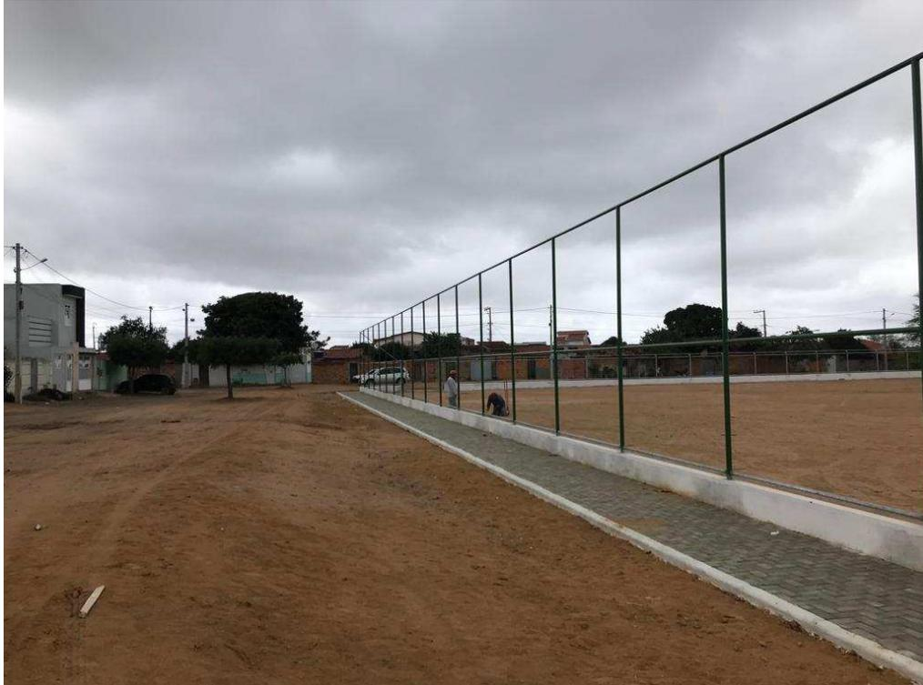
**Foto 02 – V Execução do alambrado e pavimentação.**
