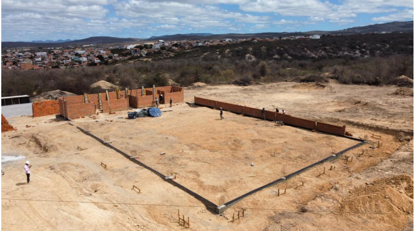
Foto 01 – Execução de quadra poliesportiva no bairro Tamboril.
