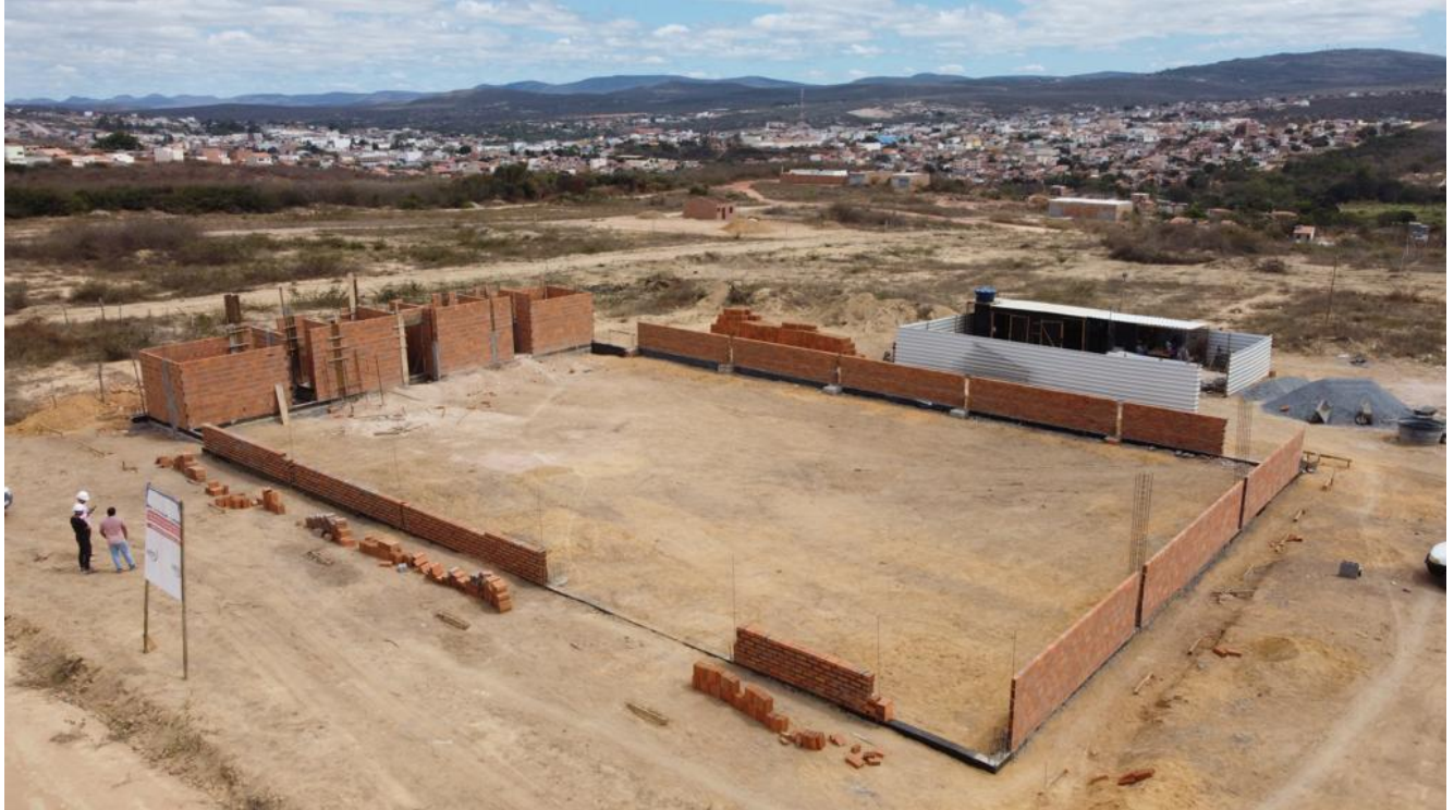
Foto 03 – Execução de quadra poliesportiva no bairro Boa Vista.
