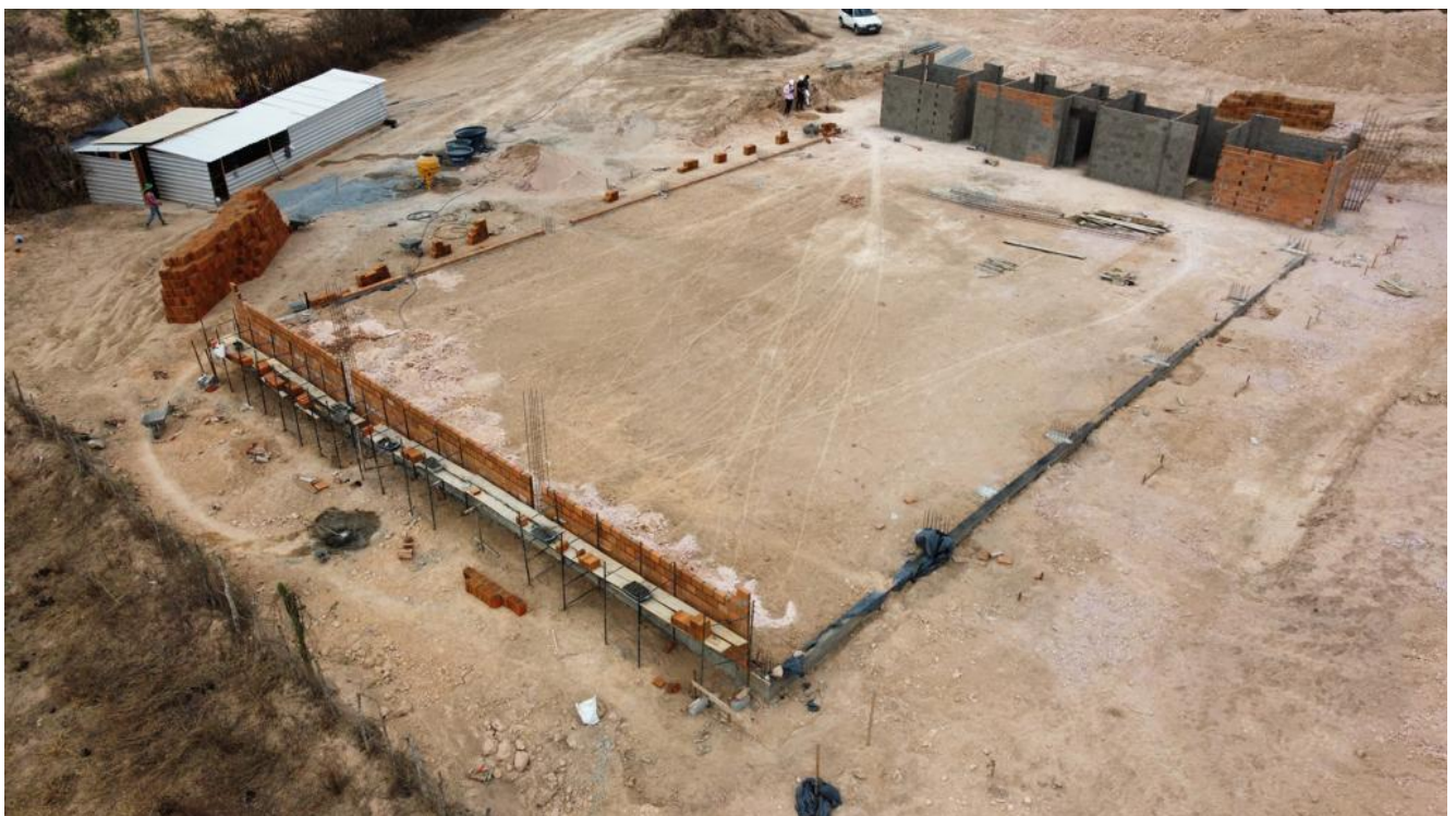
Foto 02 – Execução de quadra poliesportiva no bairro Barreirinho.
