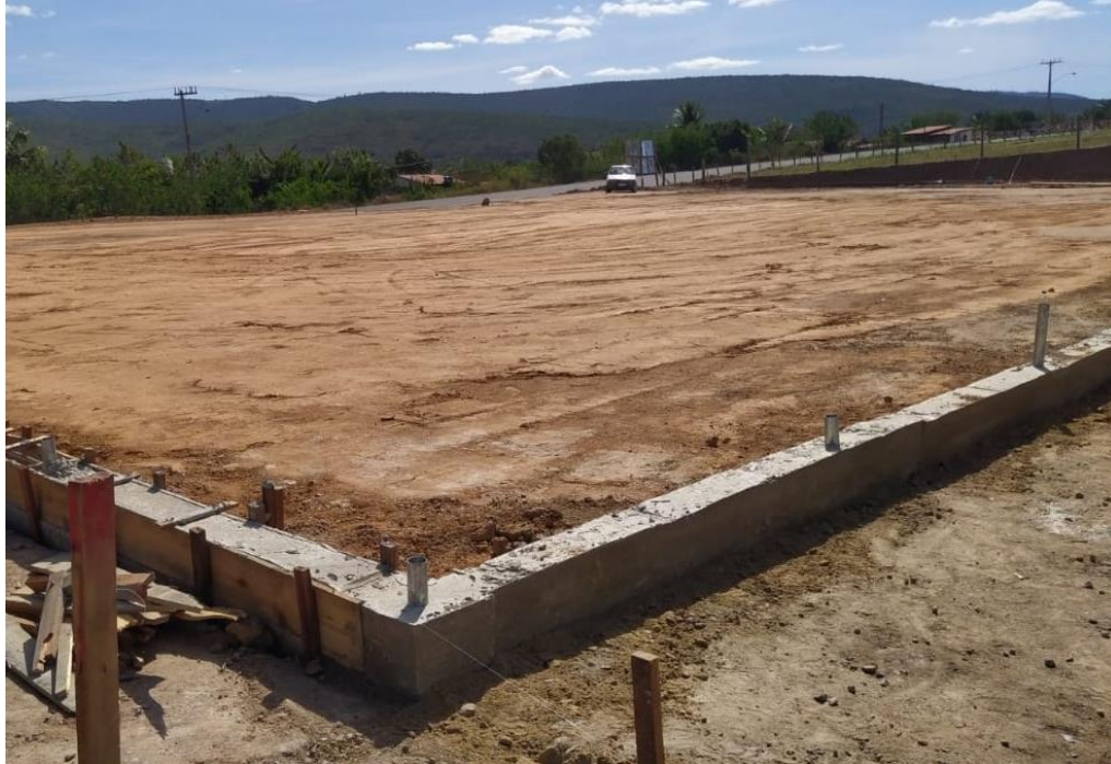
Foto 01 – Execução de fundação para alambrado.
