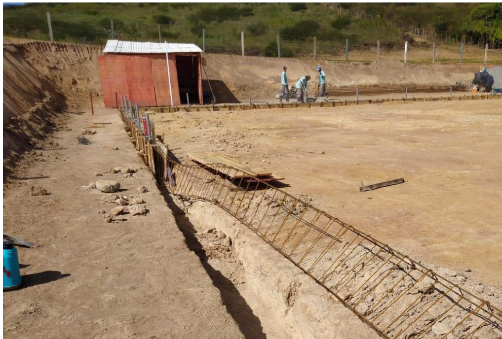
Foto 02 – Execução de armação de fundação para alambrado.
