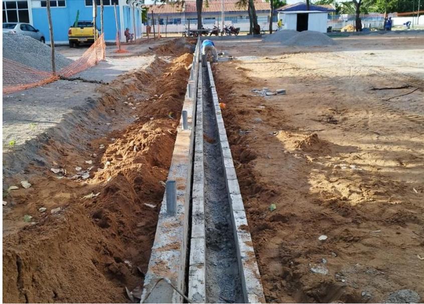
**Foto 02 – Construção de fundação e mureta do alambrado – Areninha.**
