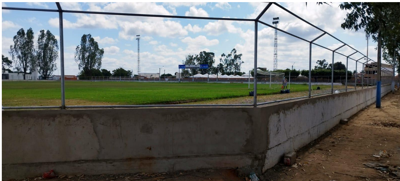
Foto 03 – Vista da estrutura do alambrado concluída, restando pintura e telas.
