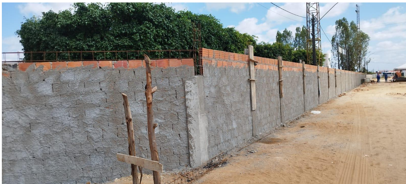
Foto 04 – Vista do muro divisório do Estádio em fase de acabamento.
