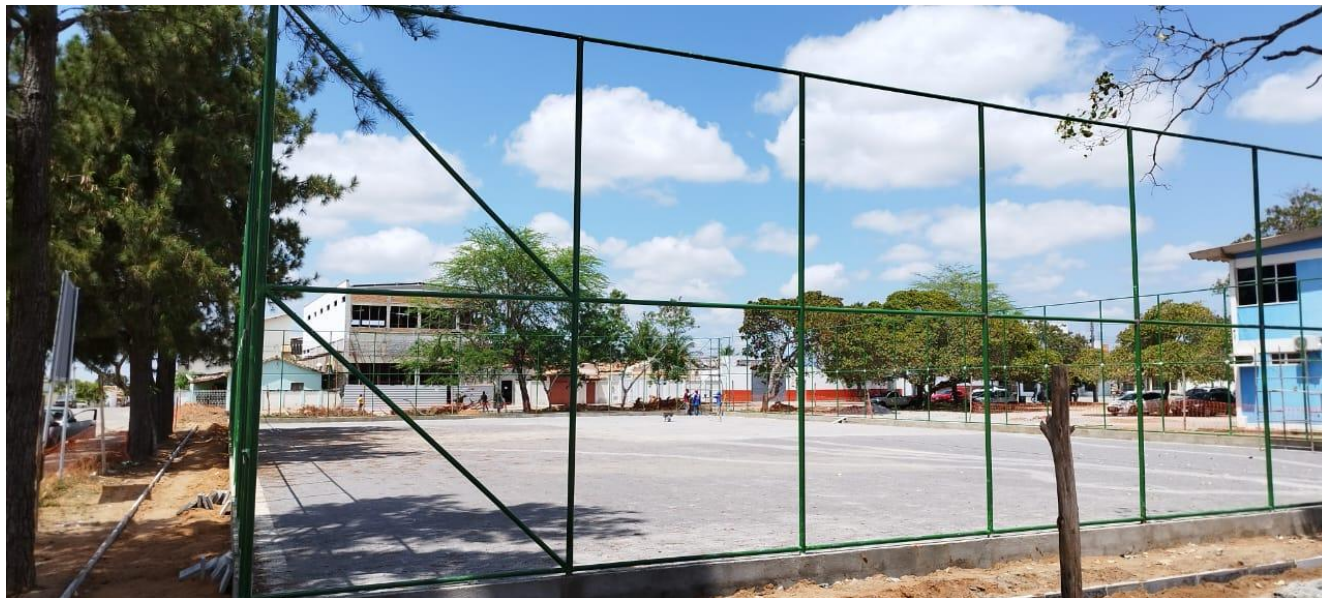
Foto 01 – Vista da base do gramado pronta com drenagem, da estrutura do alambrado e das guias para o intertravado da Areninha.
