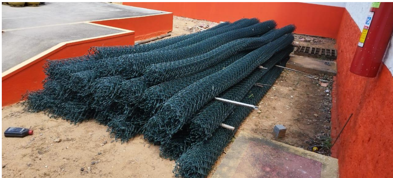
Foto 02 – Vista das telas do alambrado a serem instaladas na Areninha.
