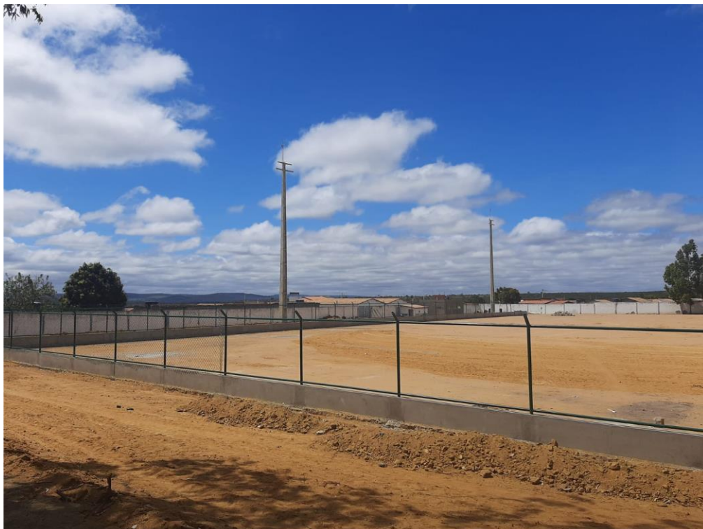
Foto 02 – Execução de alambrado com mureta e sistema de iluminação.
