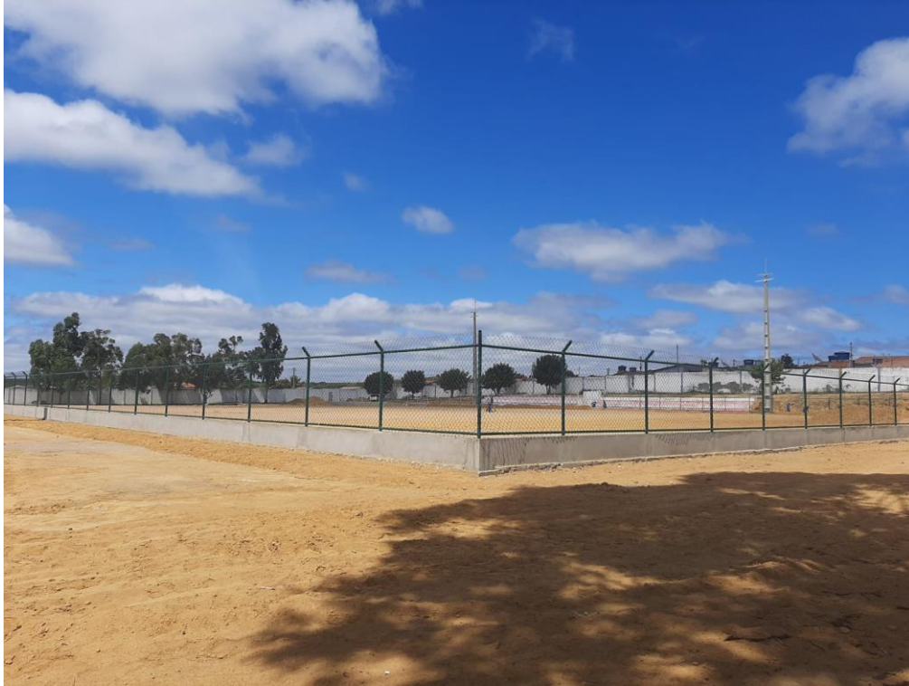
Foto 02 – Execução de alambrado com mureta e sistema de iluminação.
