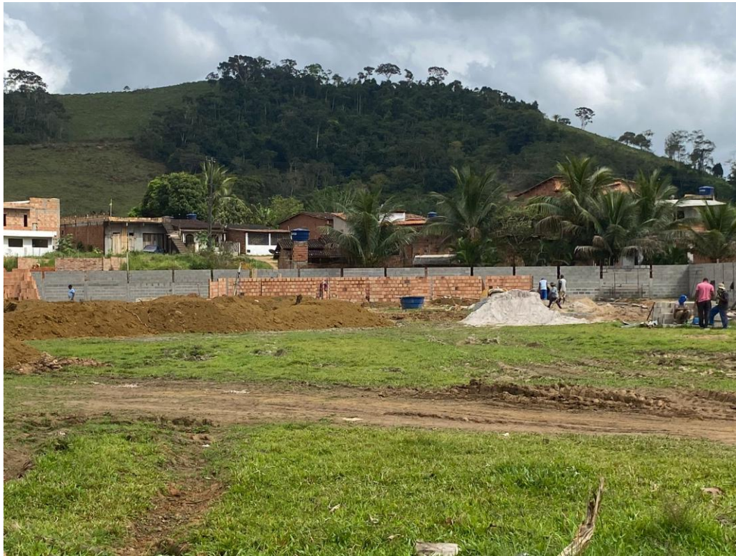
Foto 02 – Fundação da arquibancada.
