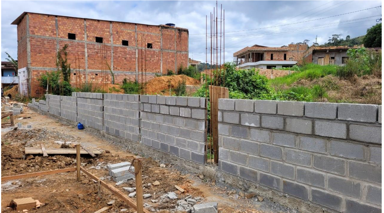
Foto 04 – Alvenaria da construção do muro no entorno.
