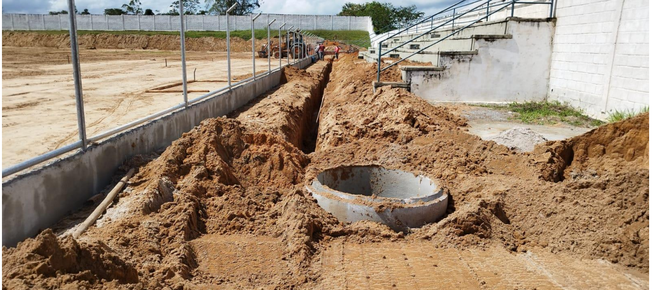
Foto 03 – Escavação de vala e colocação de manilha para implantação de poste.
