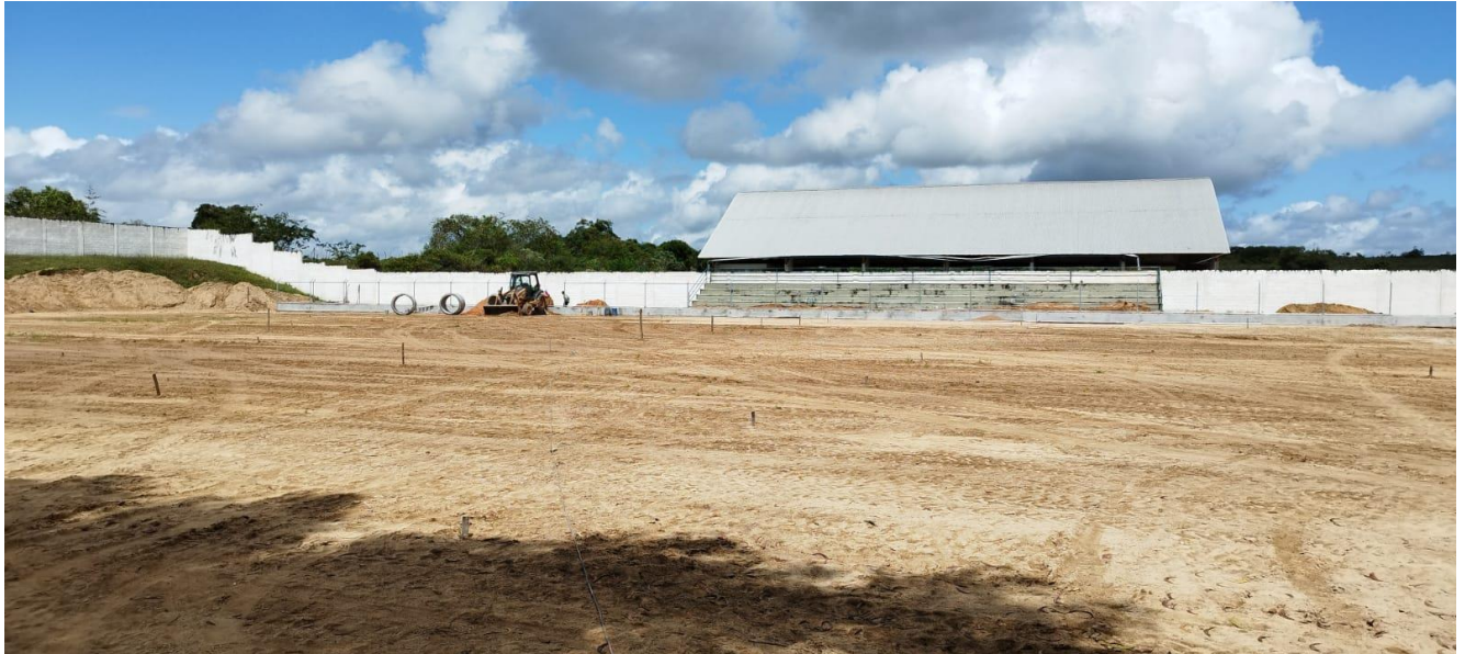
Foto 02 – Execução de alambrado com mureta.
