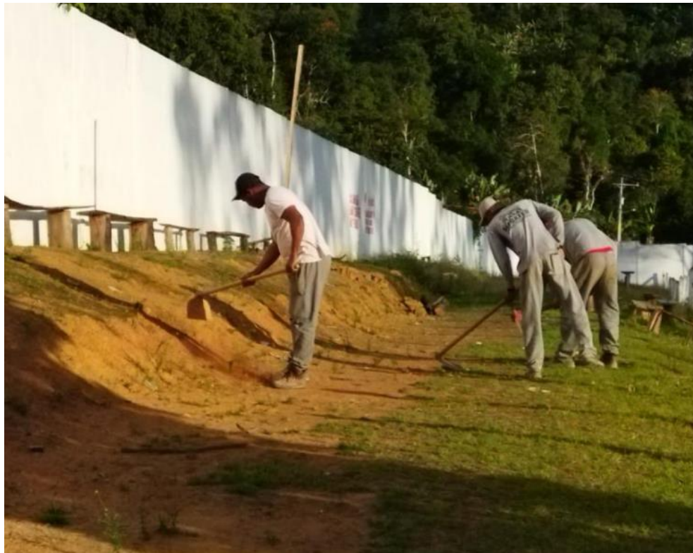
Foto 01 – LIMPEZA DO TERRENO.
