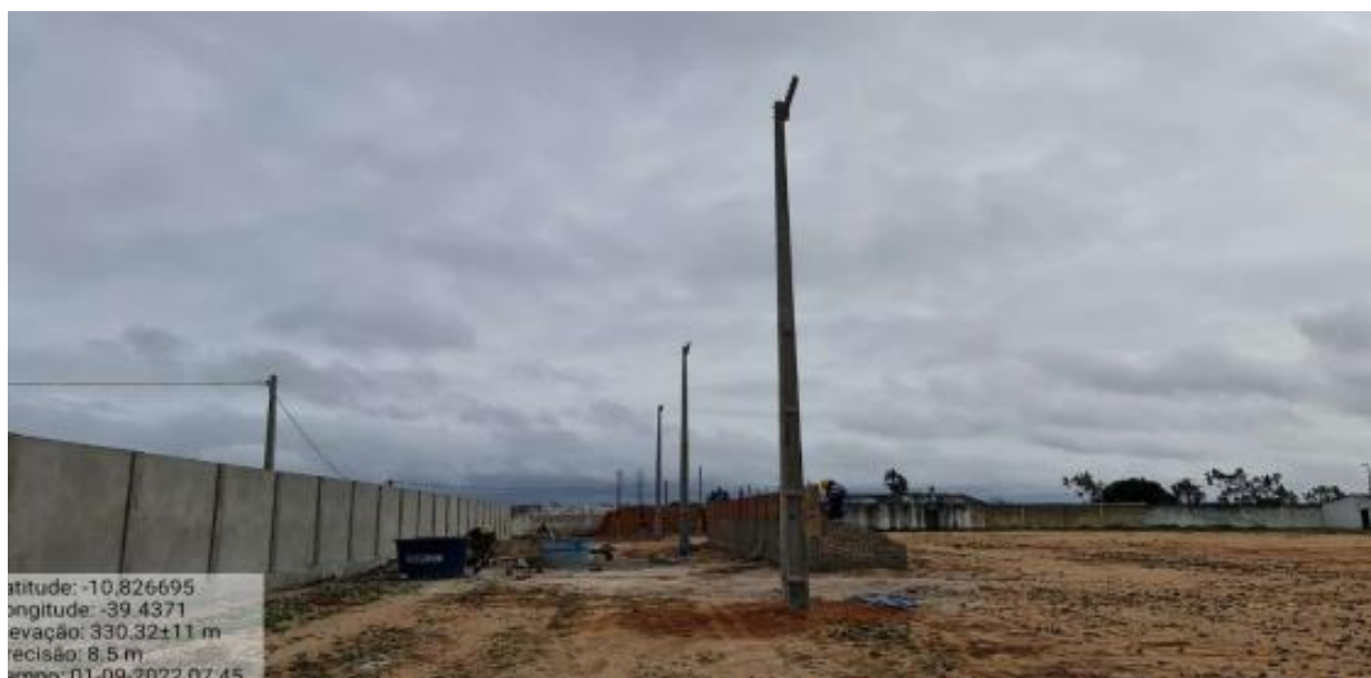
Foto 06 – Implantação dos postes de iluminação.
