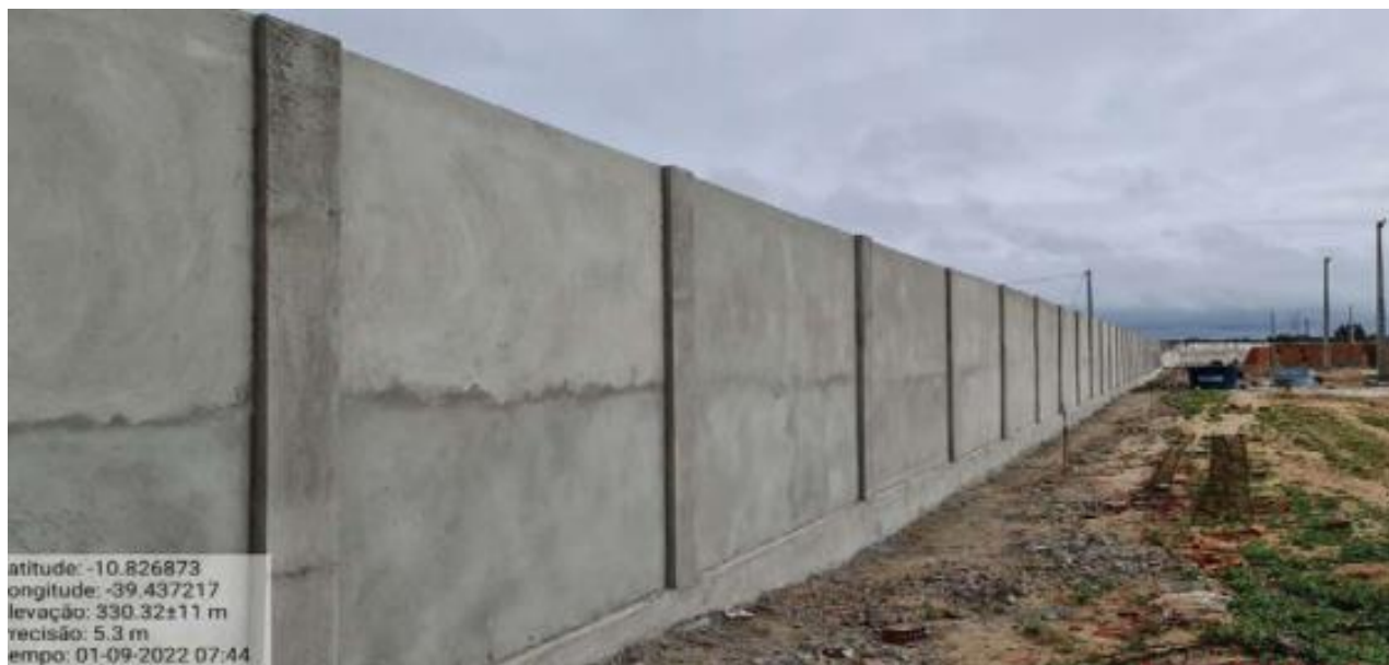
Foto 04 – Complementação do muro de entorno.
