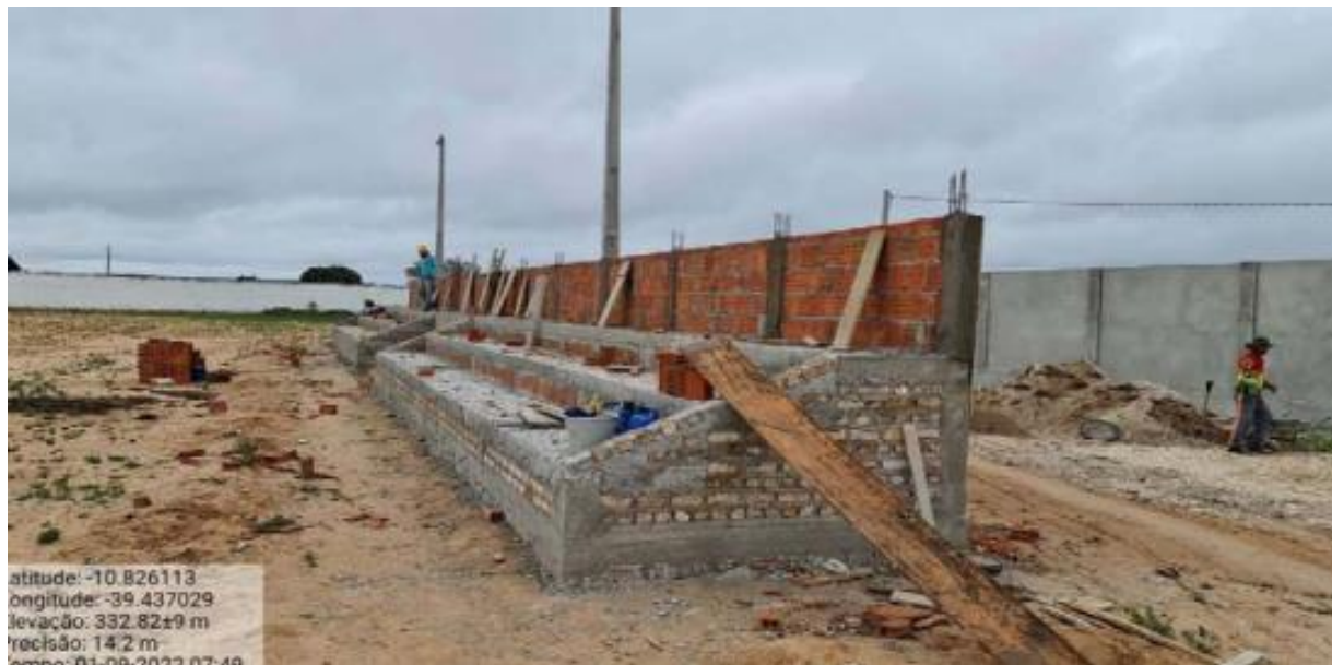
Foto 03 – Construção da arquibancada.
