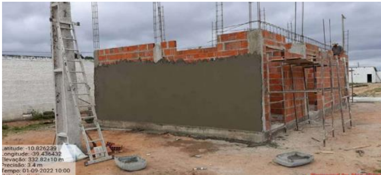
Foto 01 – Construção de vestiário, tipo c4.
