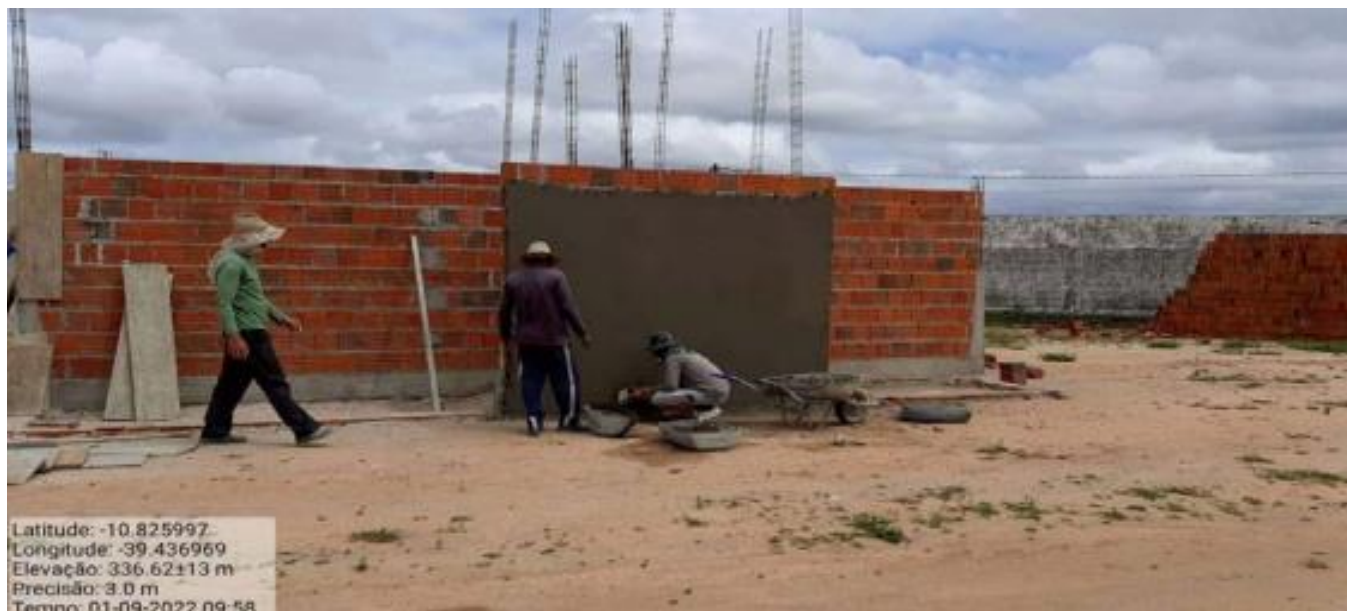
Foto 02 – Construção de sanitário público.
