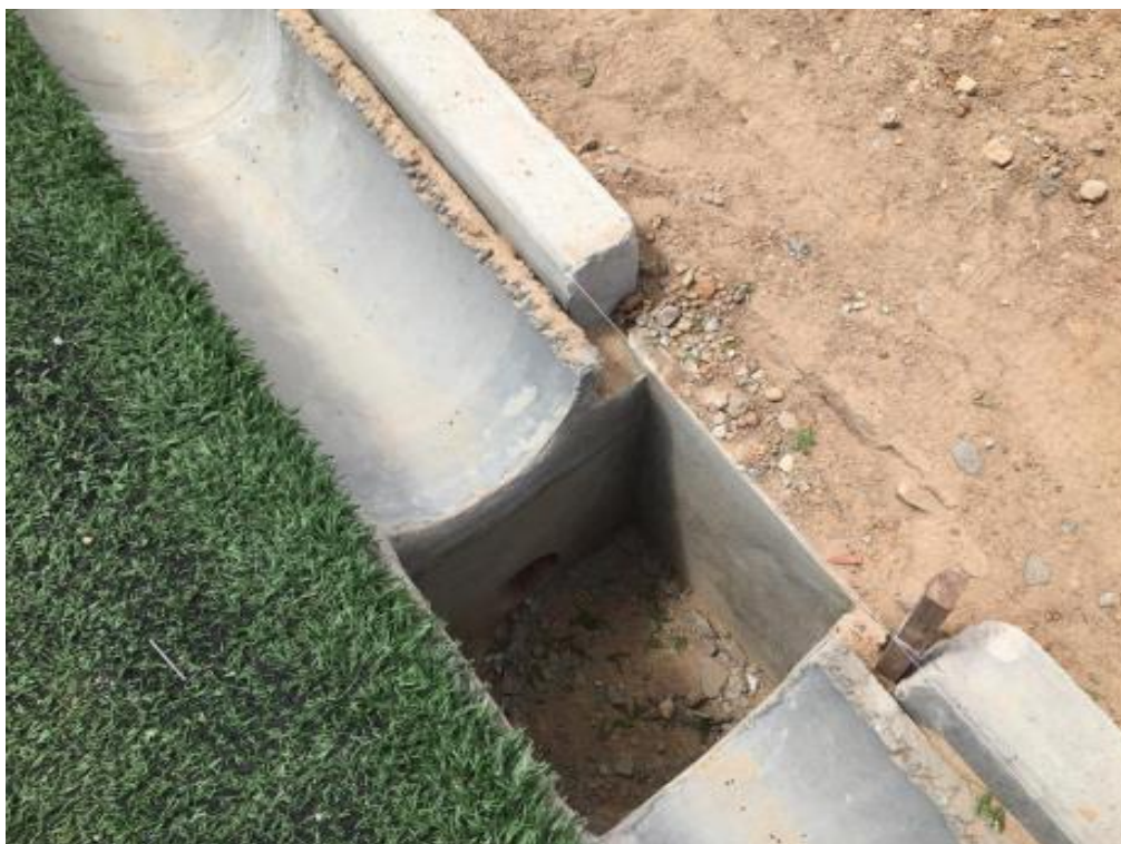
Foto 02 – Execução de caixa hidráulica enterrada.
