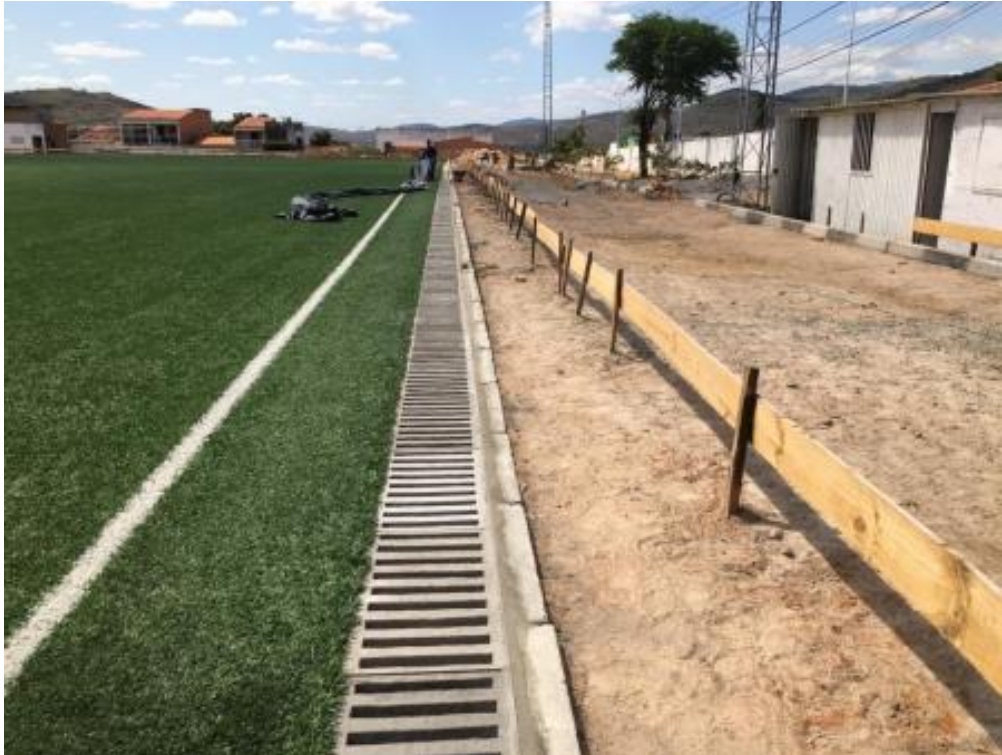
Foto 01 – Colocação de grelha pré-moldada em concreto.
