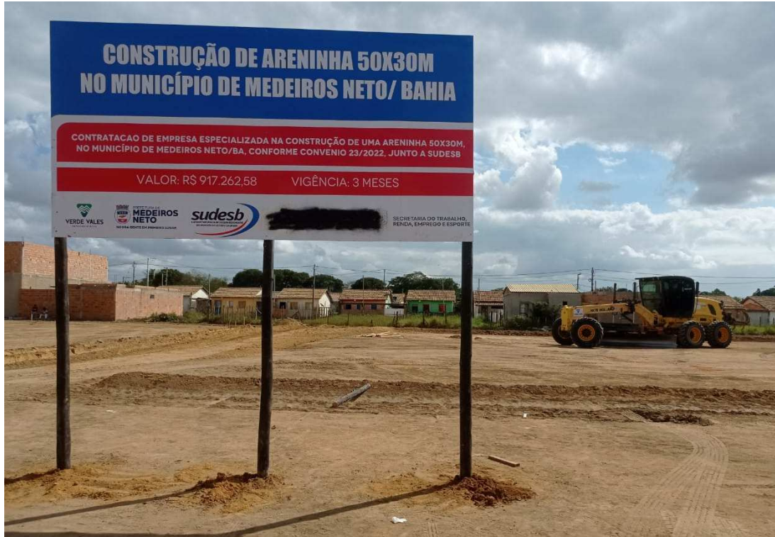
Foto 02 – Vista da construção do alambrado
