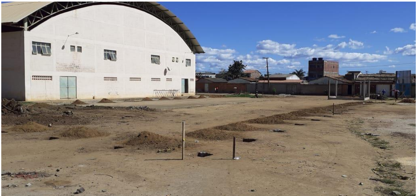
Foto 02 – Escavação para fundação do campo Society.
