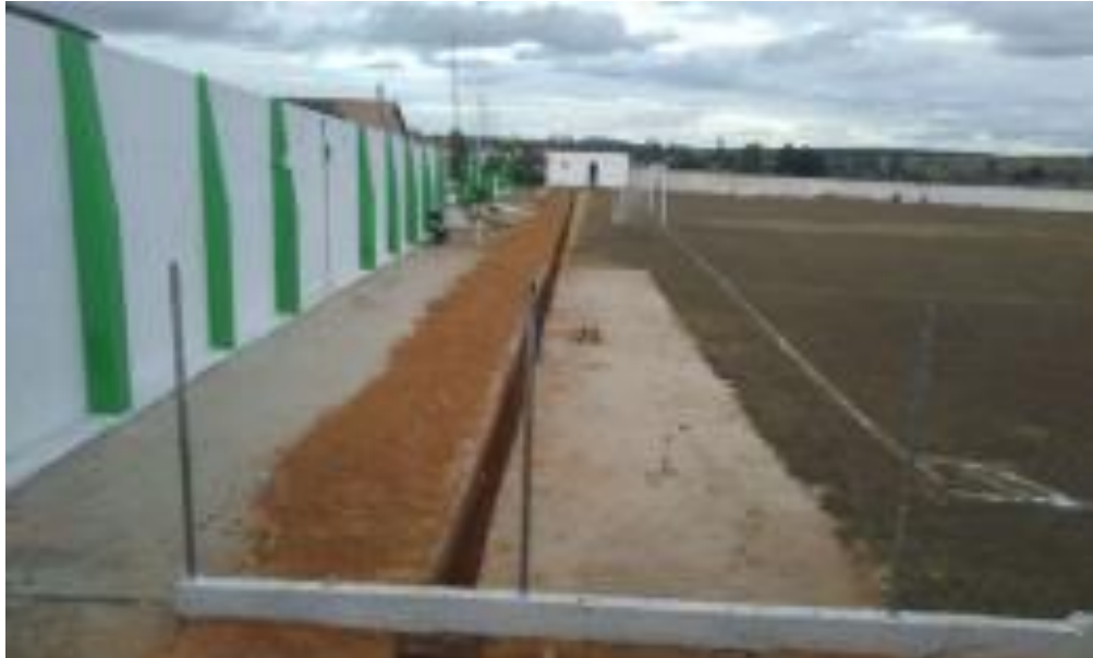
Foto 02 – Instalação de poste.
