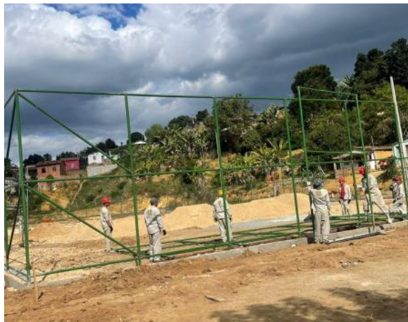
Foto 03 – INSTALAÇÃO DO CABO DE COBRE.
