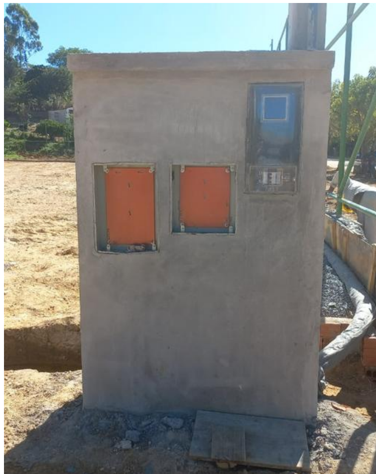
Foto 04 – ALVENARIA PARA REDE ELÉTRICA.
