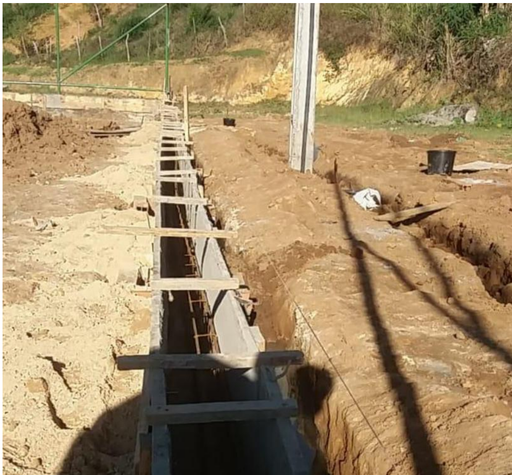
Foto 06 – FUNDAÇÃO DO ALAMBRADO.
