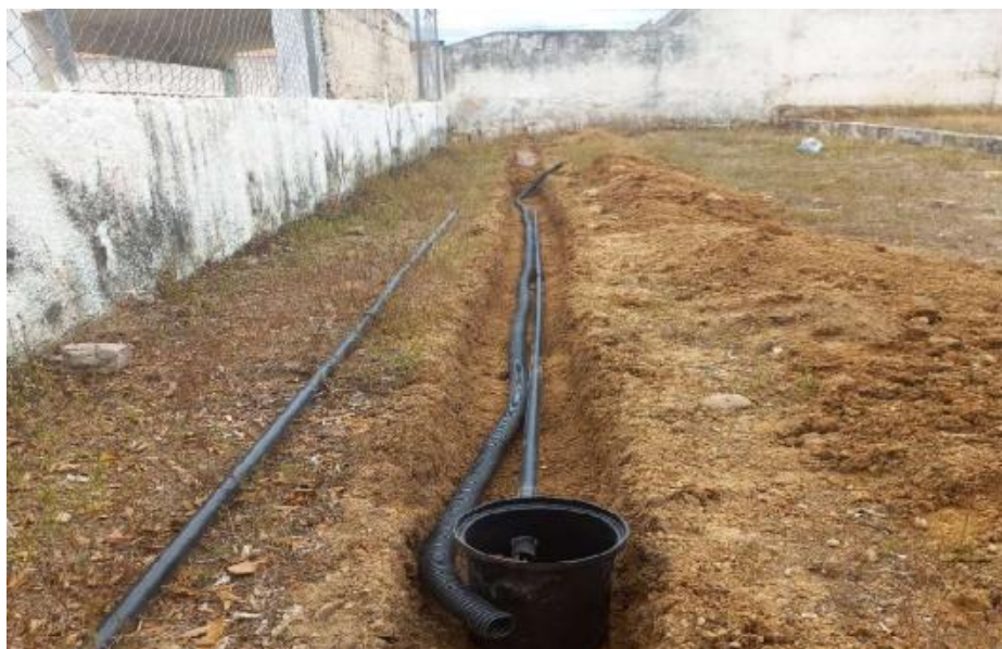
Foto 02 – Escavação e eletrodutos.
