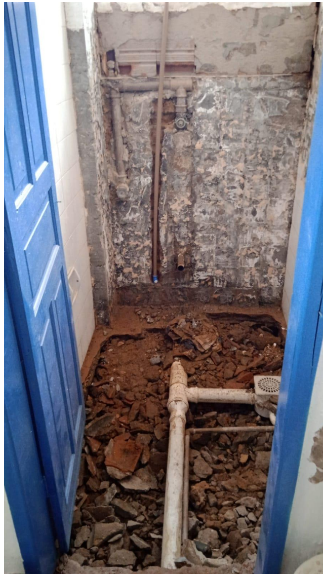
Foto 03 – Revisão de pontos hidráulicos.
