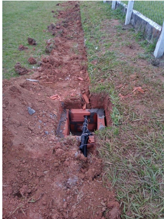
Foto 01 – Escavação e reaterro de vala e caixa elétrica enterrada.
