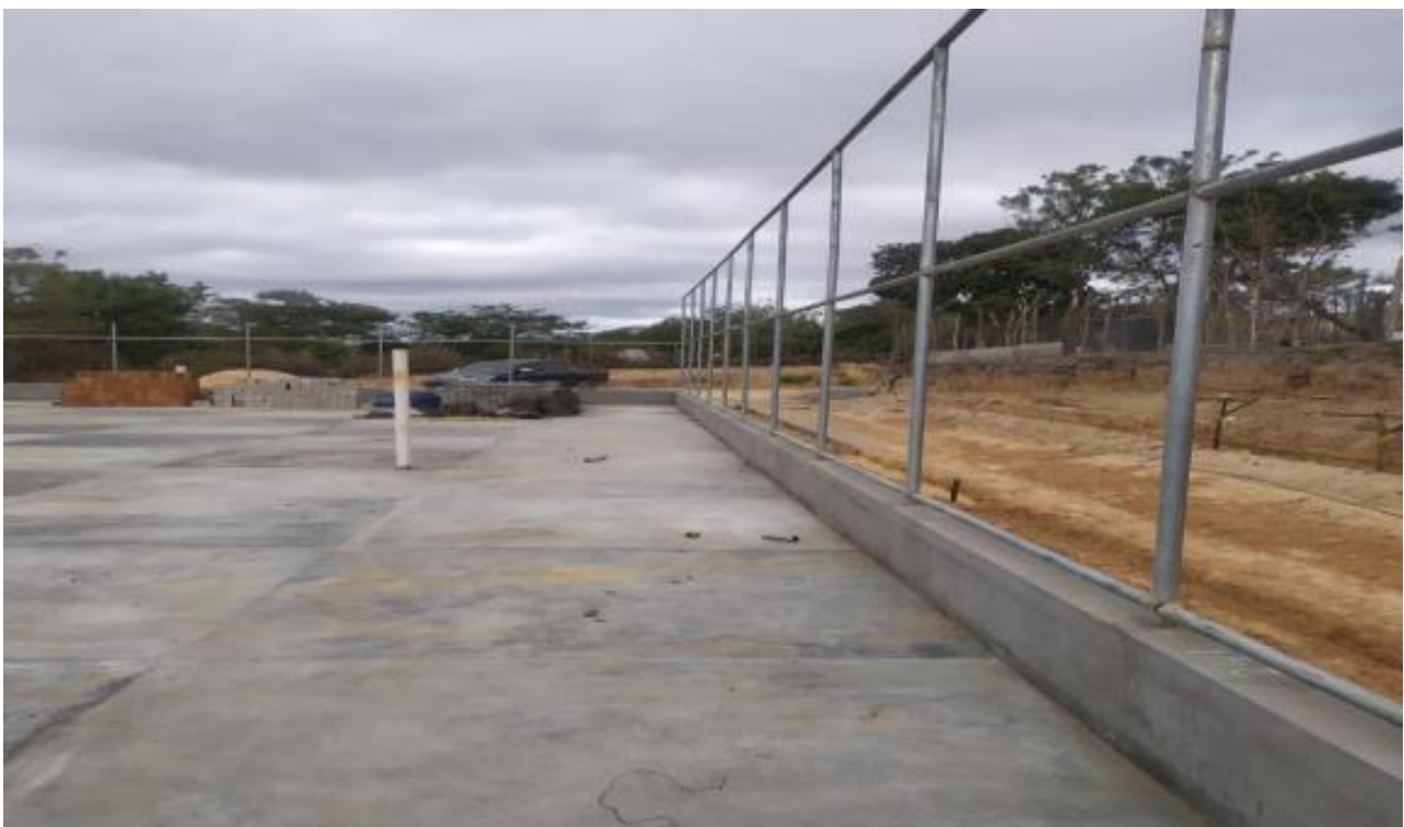
Foto 02 – Piso, mureta e tubos para alambrado.
