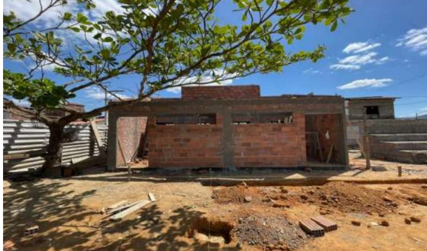
Foto 02 – ARQUIBANCADA DE 30M E 3 DEGRAUS.
