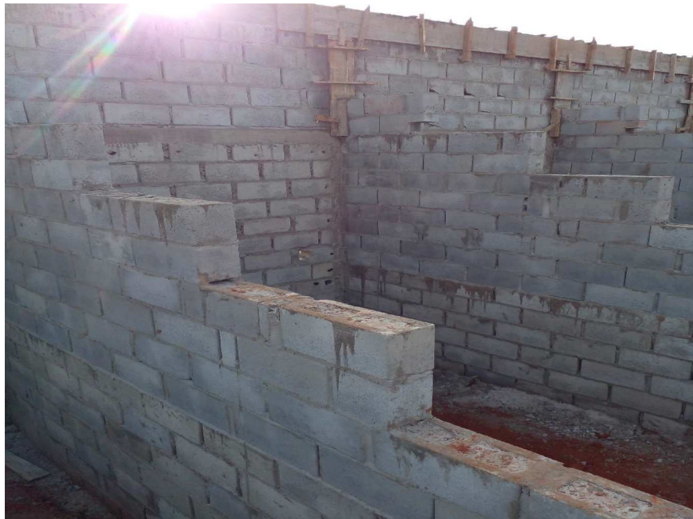
Foto 03 - Vista da construção da arquibancada.
