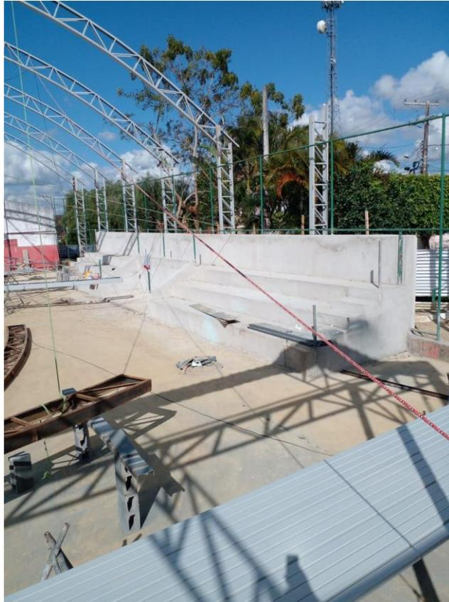
**Foto 02 – INSTALAÇÃO DOS PILARES METÁLICOS.**
