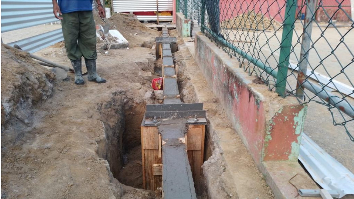
Foto 08 – EXECUÇÃO DA FUNDAÇÃO PARA COBERTURA DA QUADRA.
