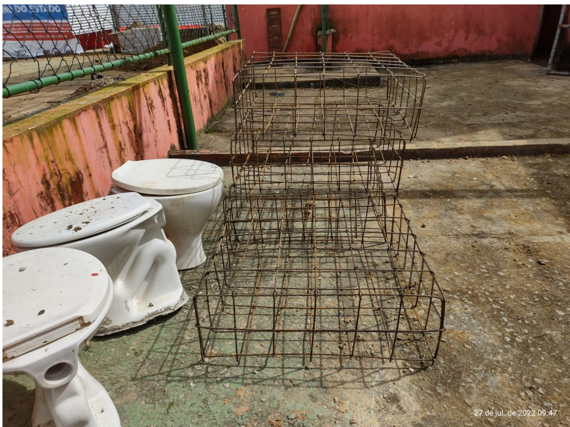
Foto 06 – EXECUÇÃO DA ARMADURA DAS SAPATAS.
