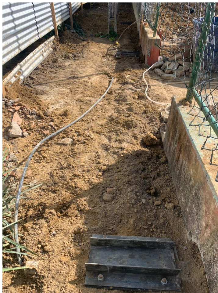
Foto 08 – EXECUÇÃO DA FUNDAÇÃO PARA COBERTURA DA QUADRA.
