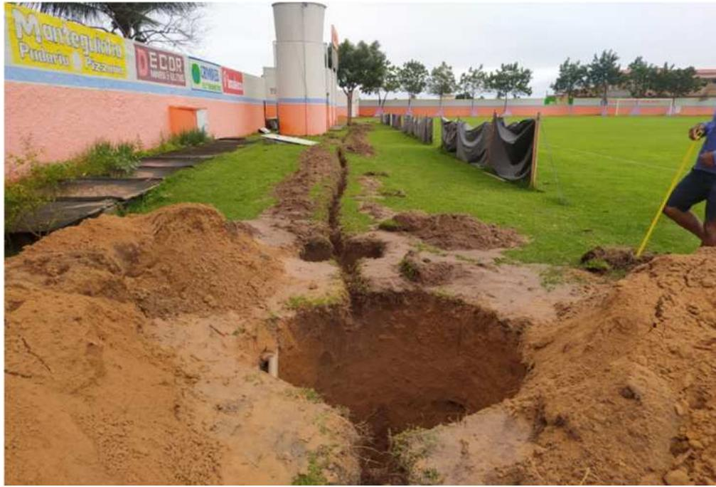
**Foto 01 – Escavação para instalação do Poste**
