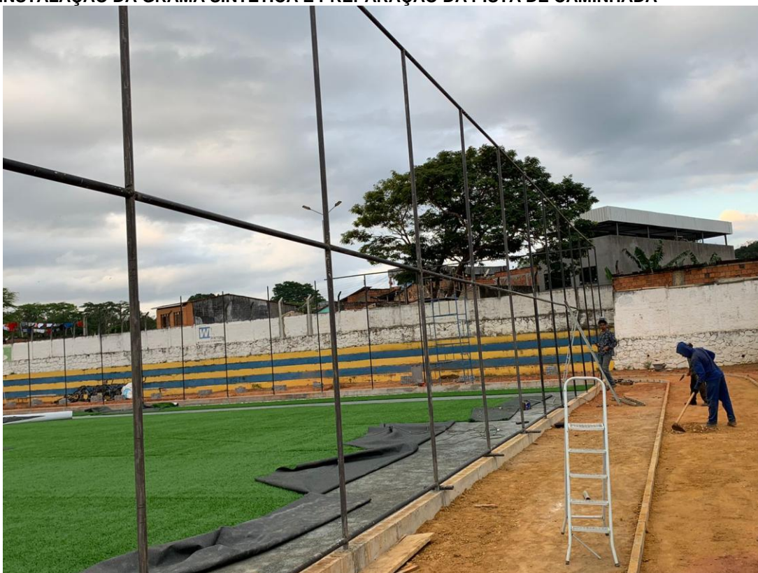
Foto 02 – INSTALAÇÃO DA GRAMA SINTÉTICA E PREPARAÇÃO DA PISTA DE CAMINHADA
