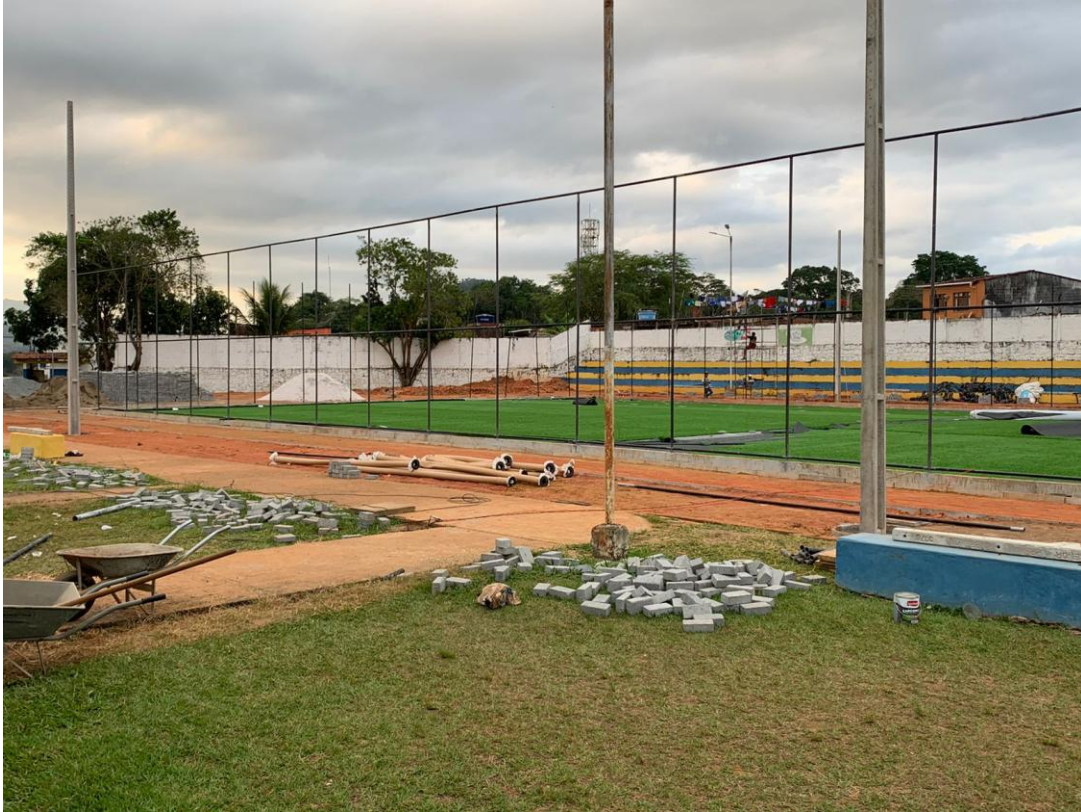
Foto 02 – INSTALAÇÃO DA GRAMA SINTÉTICA E PREPARAÇÃO DA PISTA DE CAMINHADA
