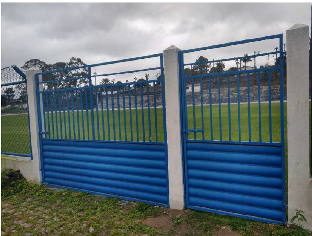
Foto 01 – Acabamento do portão do Campo.
