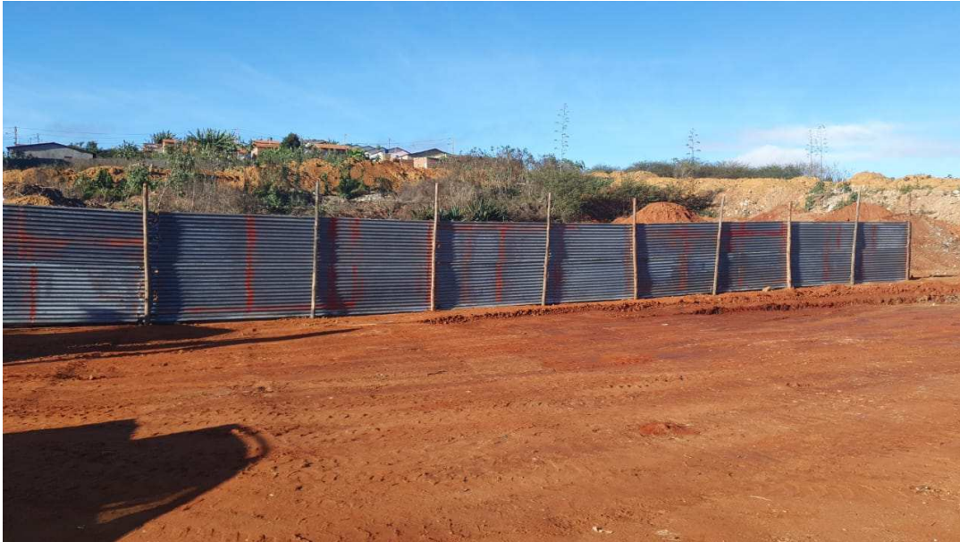
Foto 05 – Fundação do Alambrado
