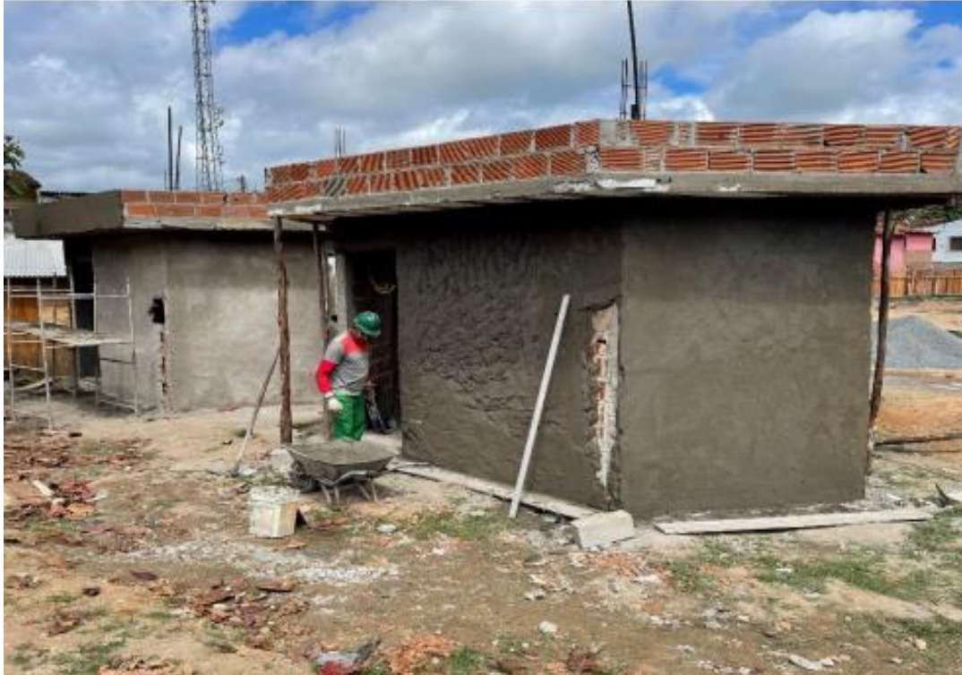
Foto 05 – Execução dos dois quiosques.
