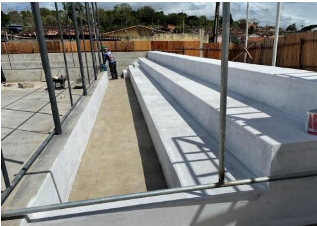
Foto 04 – Recuperação da arquibancada e do alambrado da quadra poliesportiva.
