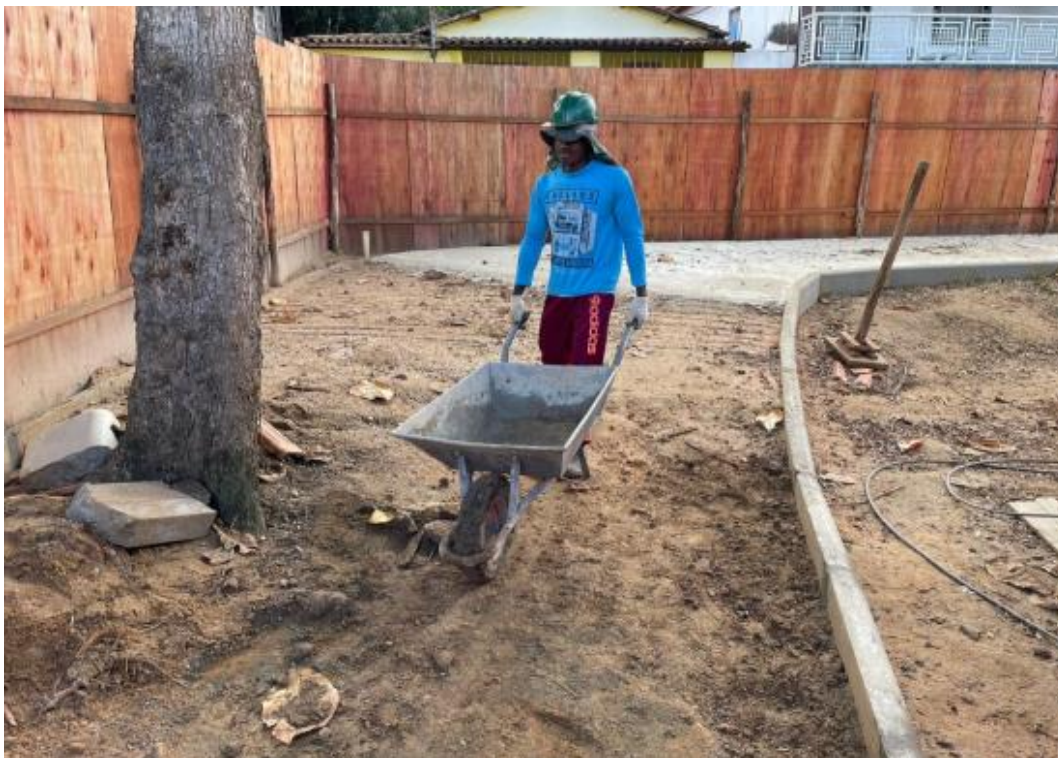
Foto 03 – Construção Parque Infantil – Fundação (viga baldrame).
