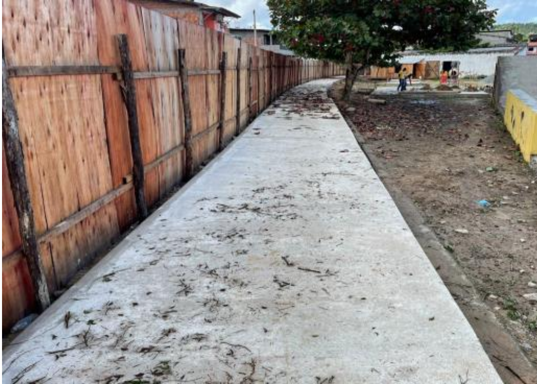
Foto 02 – Pista de Cooper – assentamento de guia (meio fio) e preparação para execução em piso de concreto.
