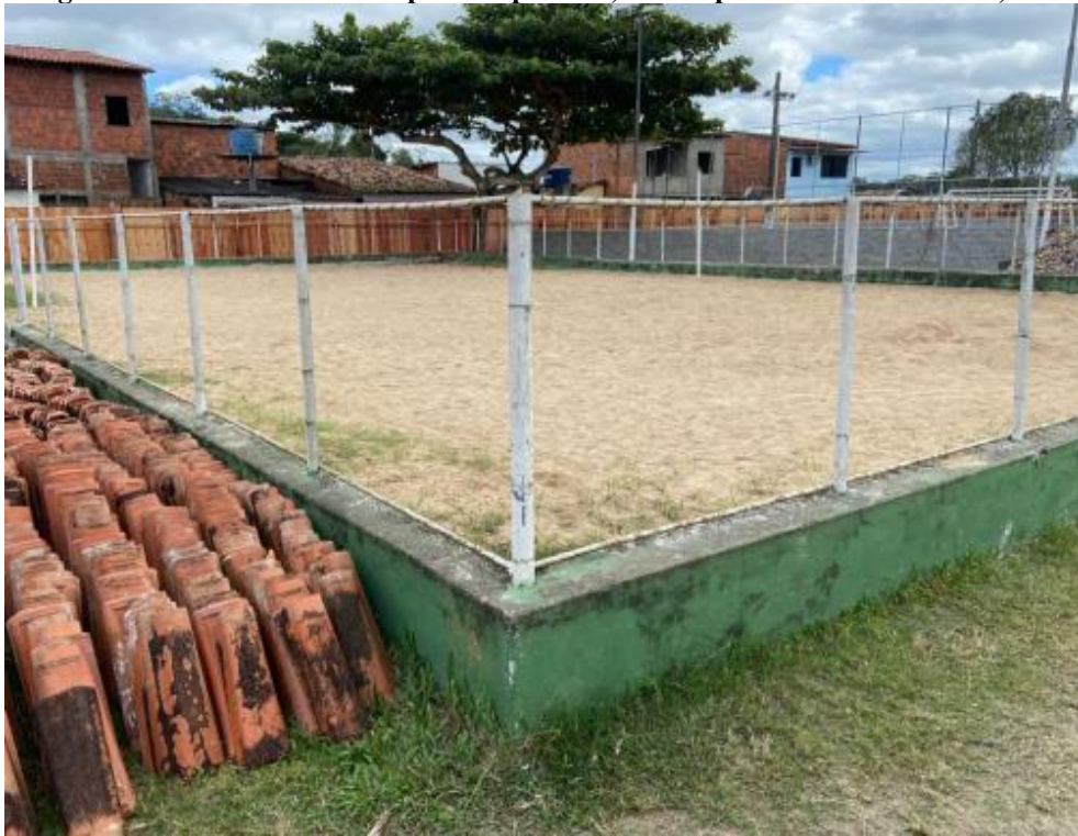
Foto 06 – Construção de quiosque – Fundação.
