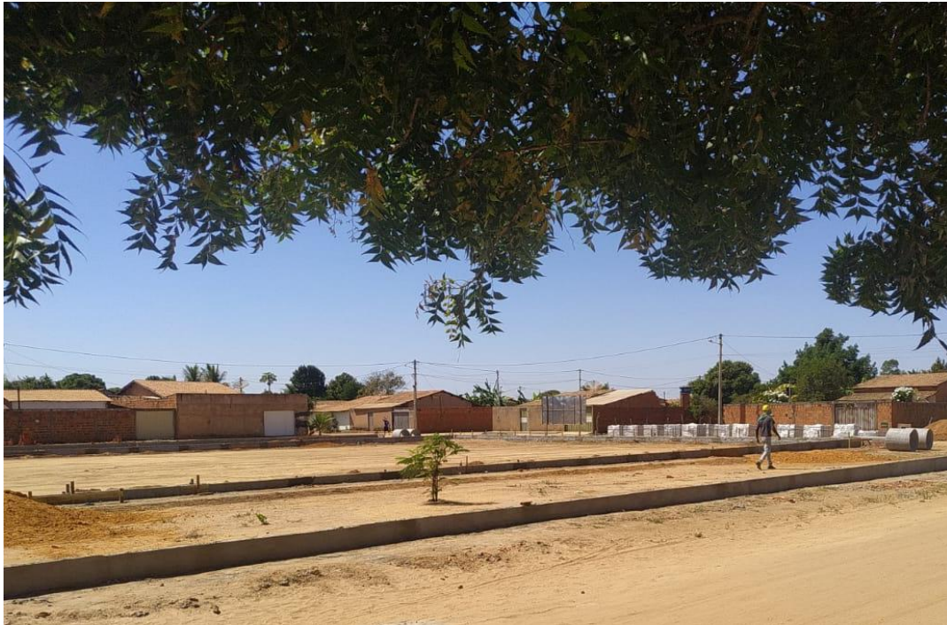
Foto 01 – Construção de base para alambrado.
