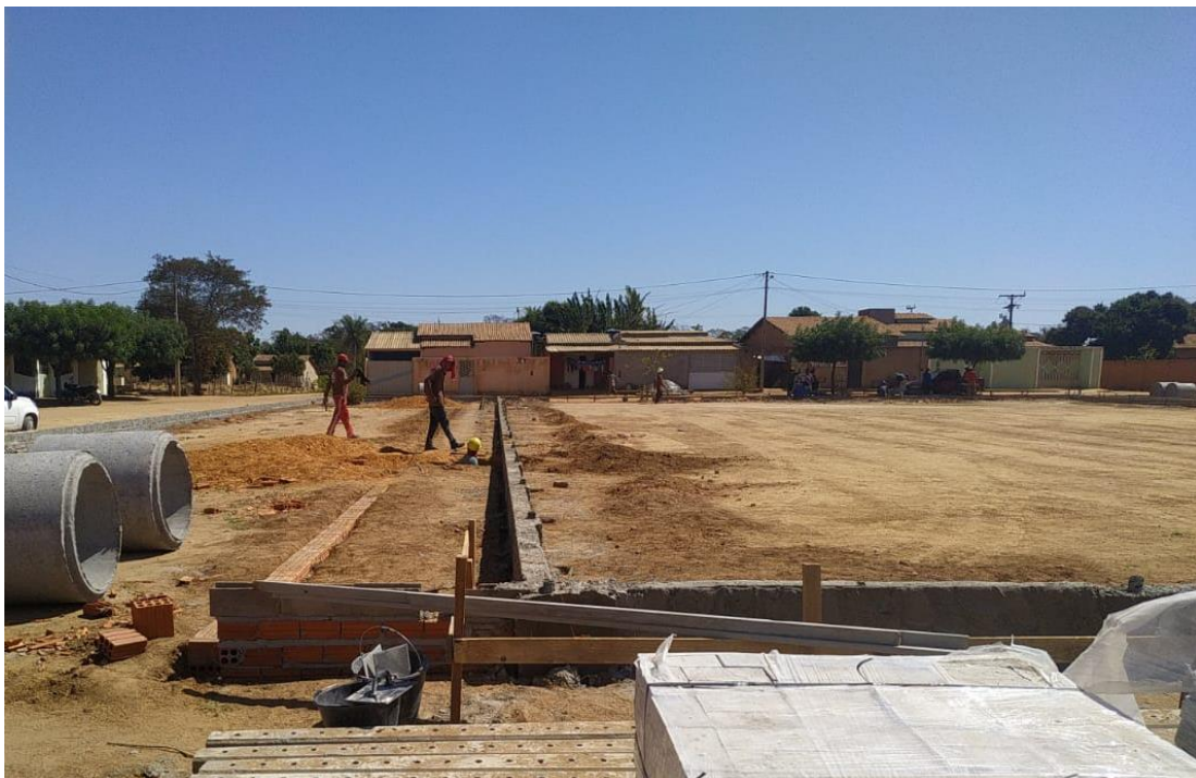
Foto 02 – Construção de base para alambrado.
