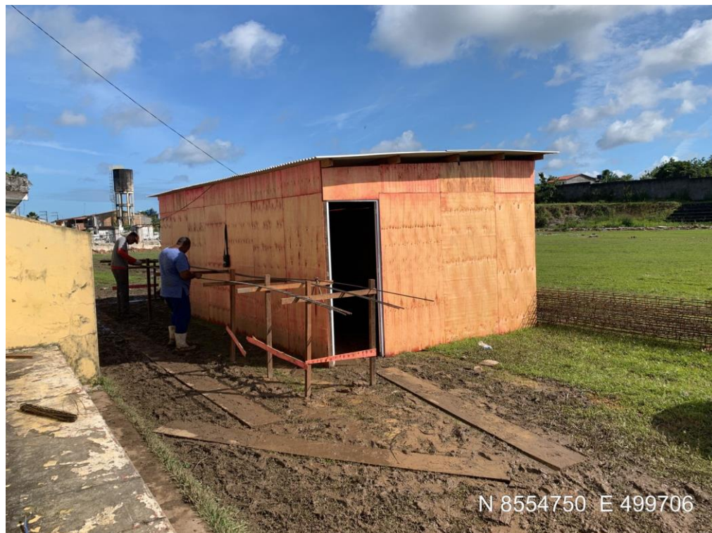
Foto 04 – Barracão de obra.
