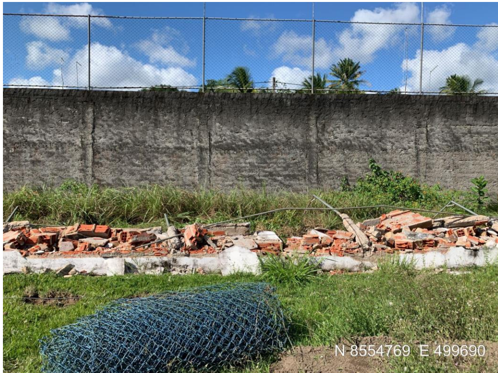
Foto 03 – Demolição do alambrado.
