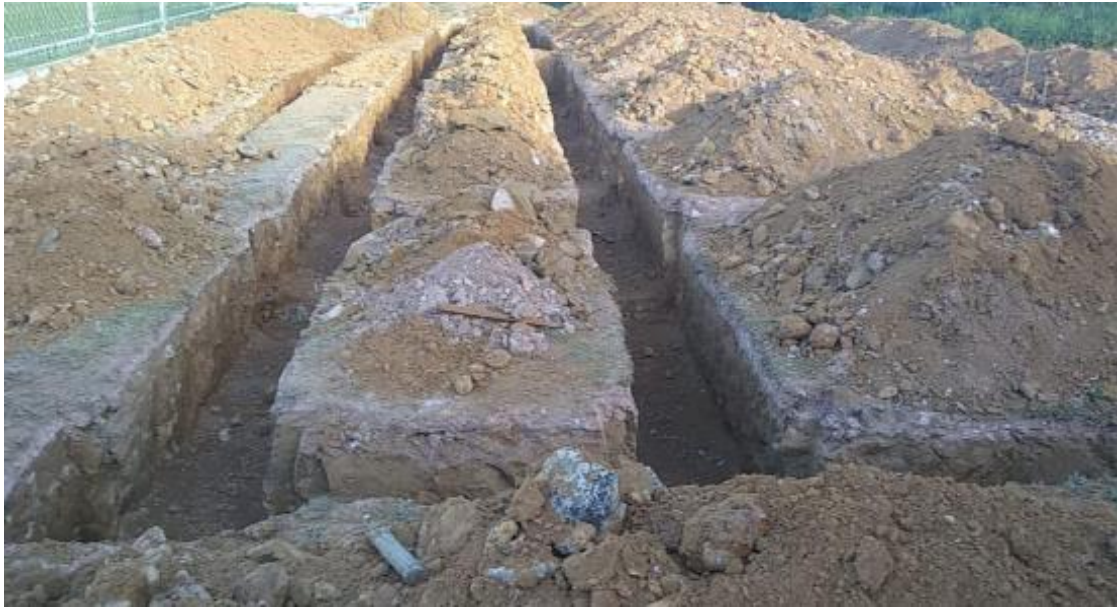
Foto 02 – Escavação de vala para fundação da arquibancada.
