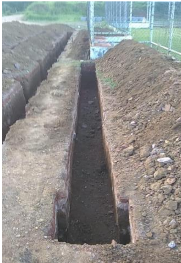
Foto 02 – Escavação de vala para fundação da arquibancada.
