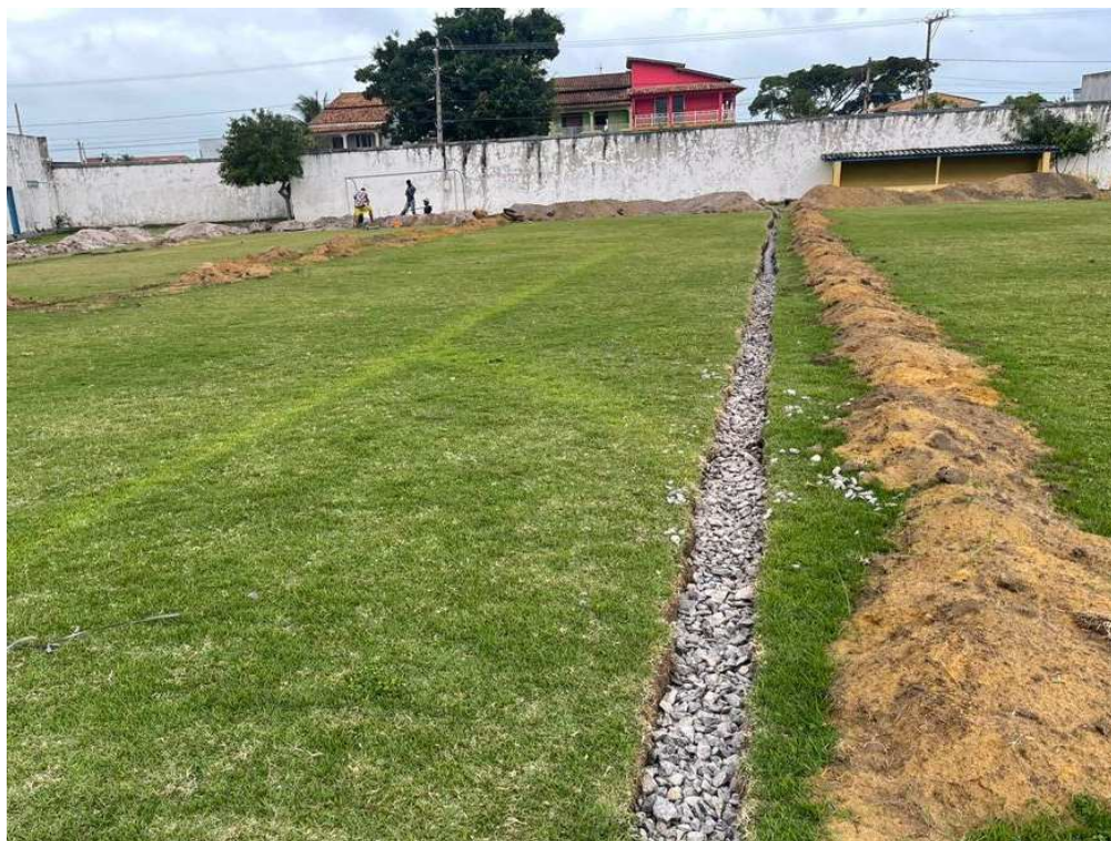
FOTO 02 – LASTRO DE BRITA DA DRENAGEM
