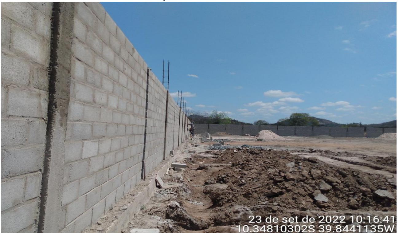
Foto 02 – Vista detalhe do muro em construção.
