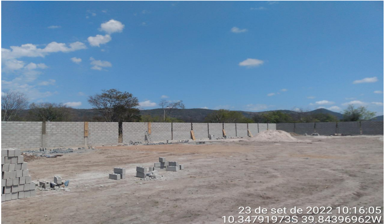
Foto 01 – Vista do terreno terraplanado e da construção do muro limítrofe do estádio.
