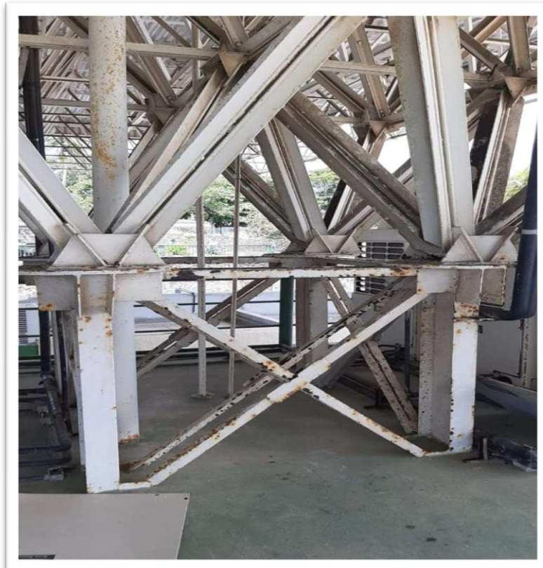
FOTO 06 - Estrutura a receber tratamento
