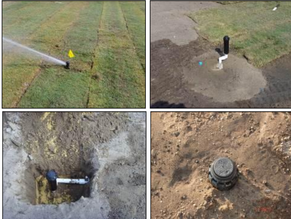
Detalhes dos aspersores no gramado
