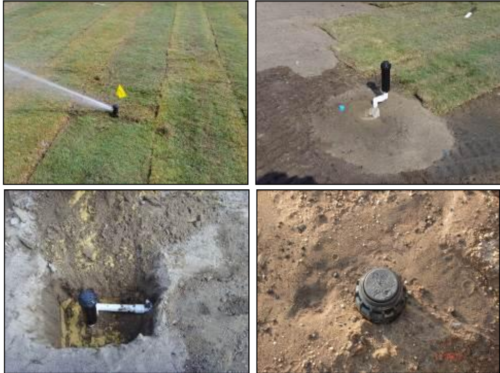
Detalhes dos aspersores no gramado
