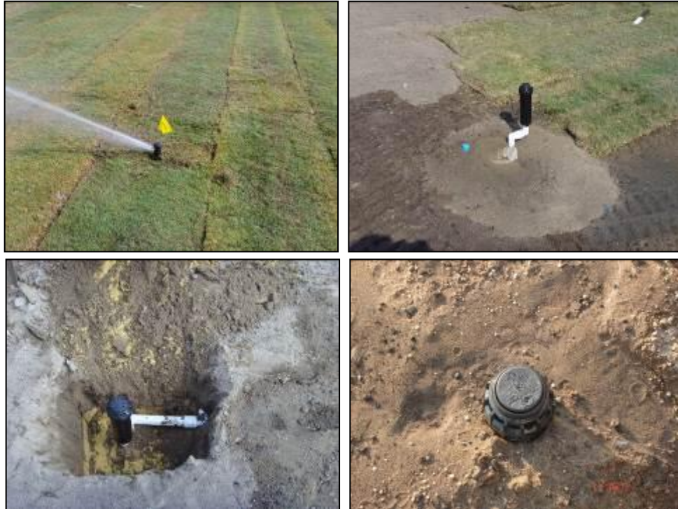
Detalhes dos aspersores no gramado
