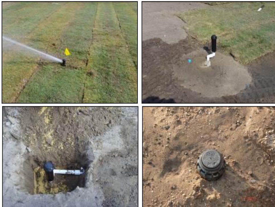
Detalhes dos aspersores no gramado
