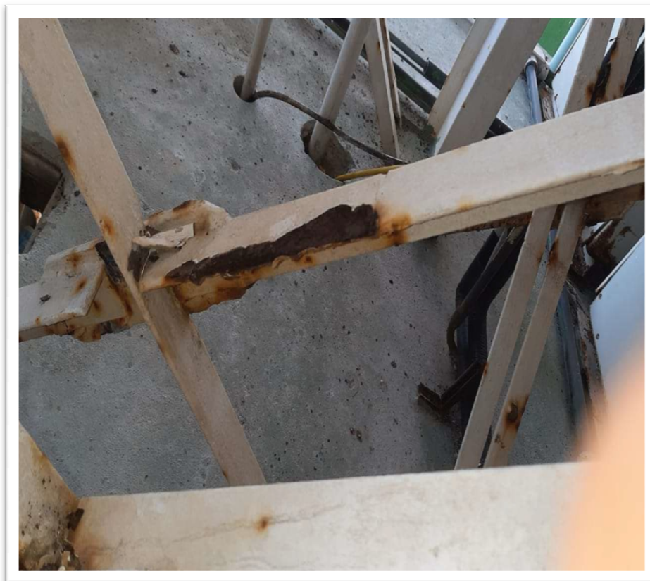
FOTO 03 – Estrutura apresentando corrosão acentuada, com perda de seção
