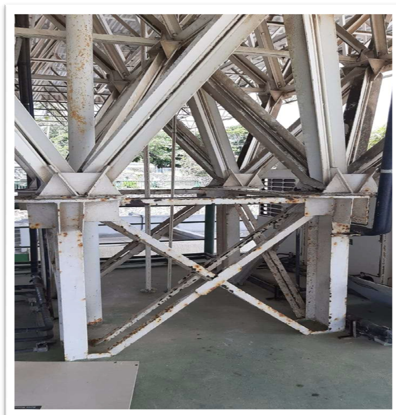
FOTO 06 - Estrutura a receber tratamento
