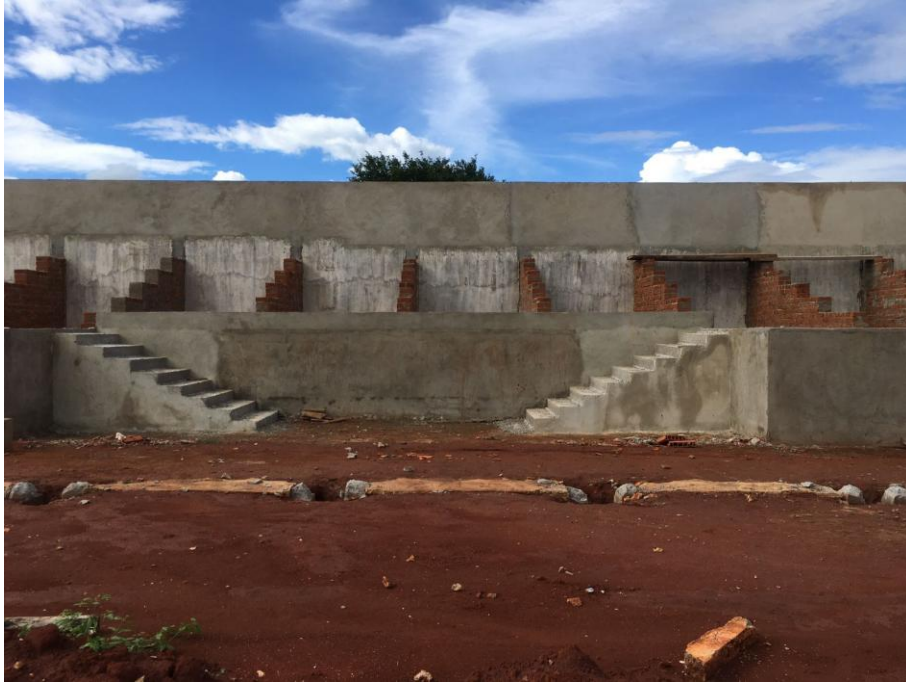
Foto 03 - Vista da construção da arquibancadas .
