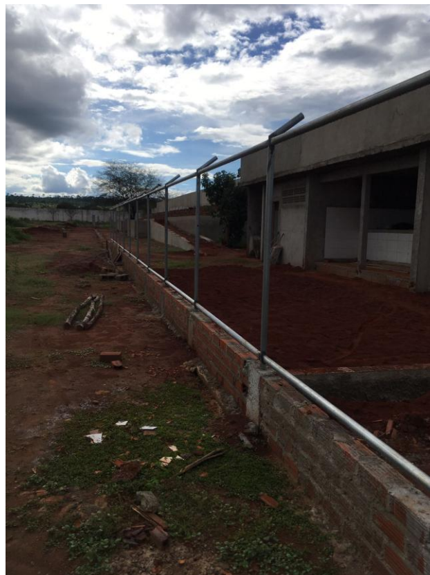
Foto 02 – construção parcial do alambrado.
