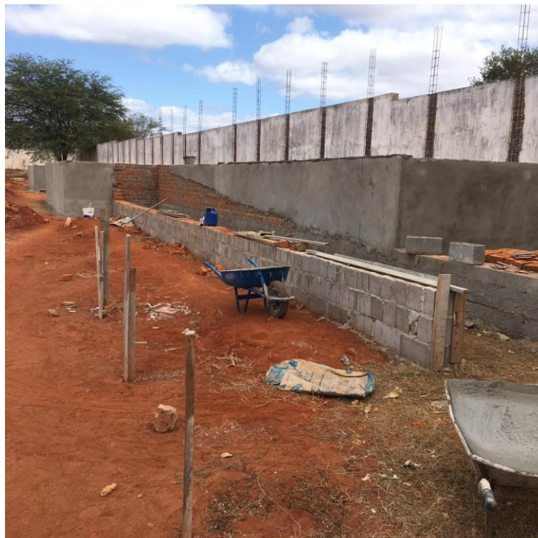
Foto 02 - inicio do revestimento da arquibancada .
