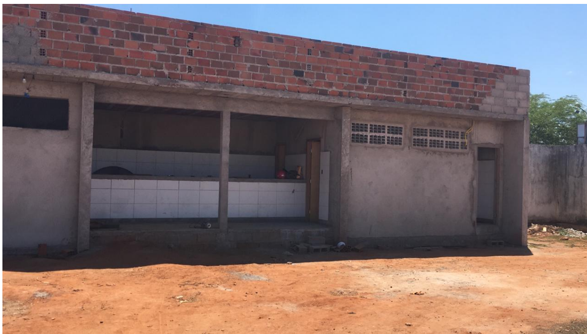
Foto 04 - Vista interna do sanitário Bar.
