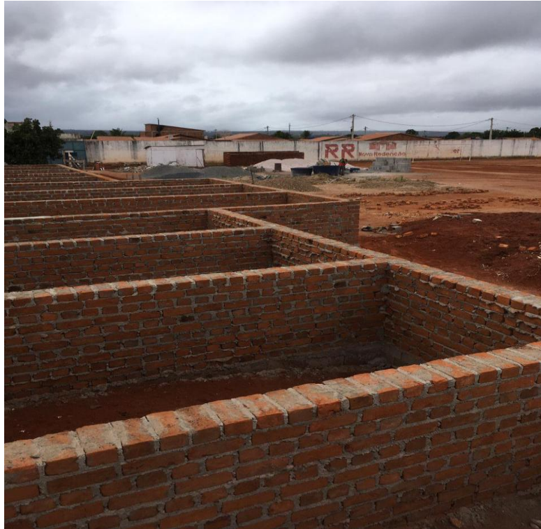
Foto 01 - Alvenaria de embasamento em tijolo maciço da arquibancada.
