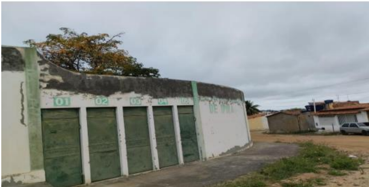
Foto 01 – Recuperação da fachada.
