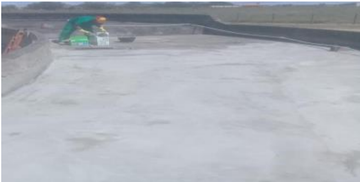
Foto 02 – Impermeabilização da laje.
