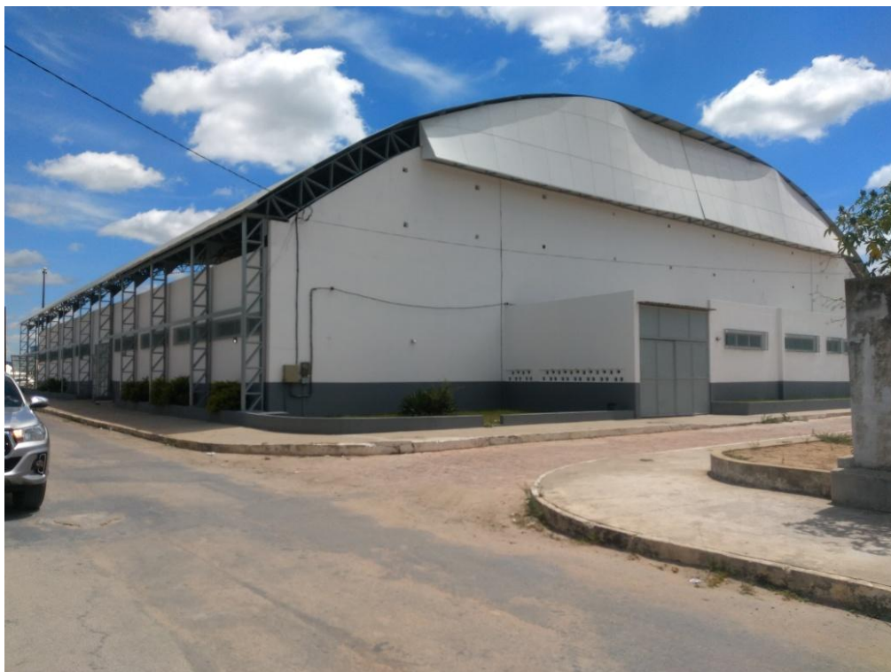
Foto 01 – Vista área externa do Ginásio reformado
