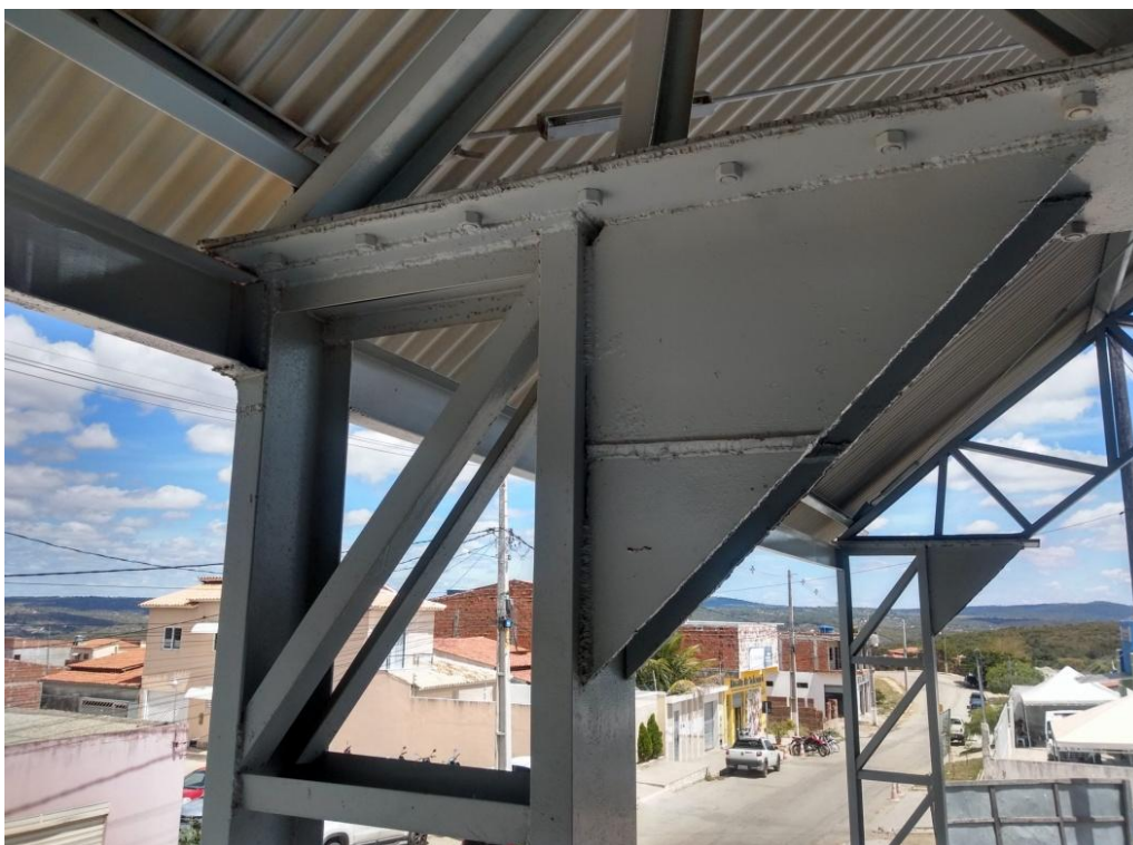
Foto 02 – Estrutura metálica da cobertura recuperada
